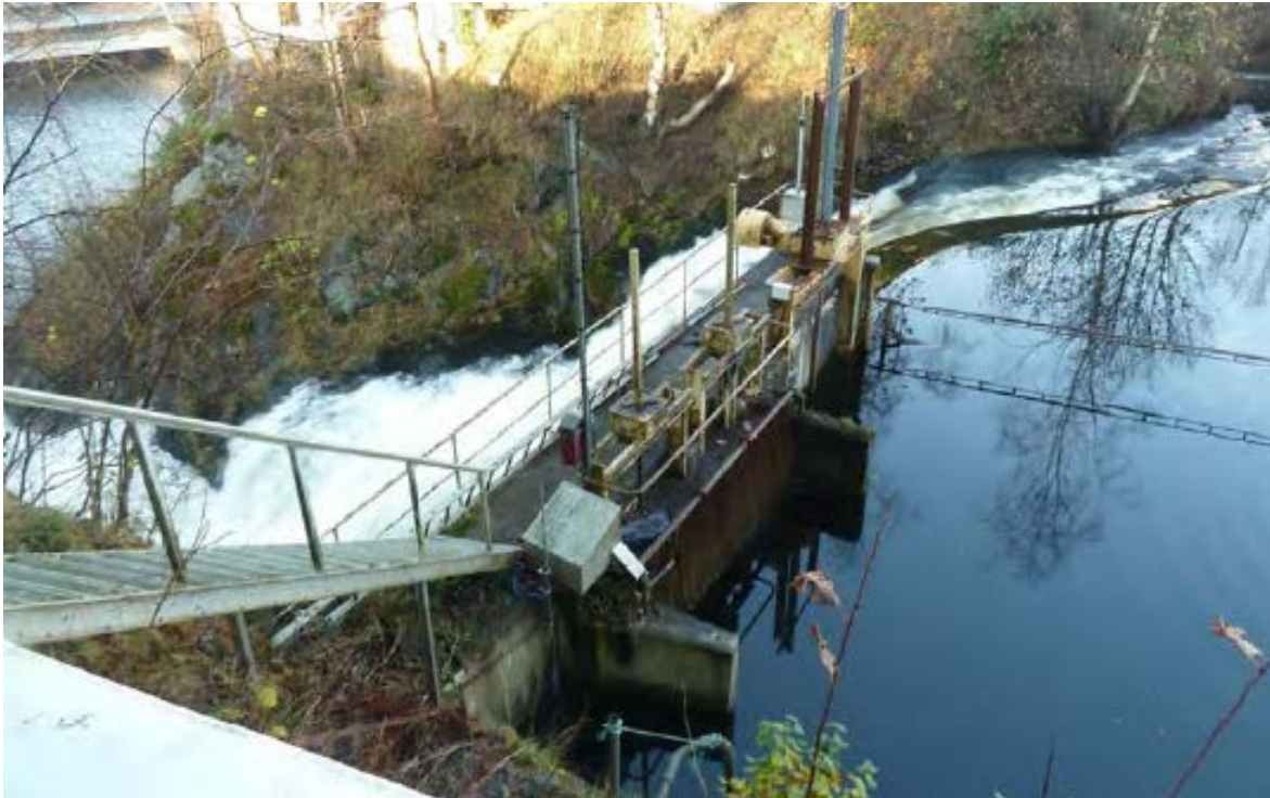
Figur 5. Hopsdammen (Foto NVE). Dagens flomløp rives. Nytt flomløp foreslås senket 0,5 m, og bygges i en bue innover i magasinet. Anslått overløpslengde 35m. Fisketrapp langs fjellet til høyre for overløpet, sett nedover.
