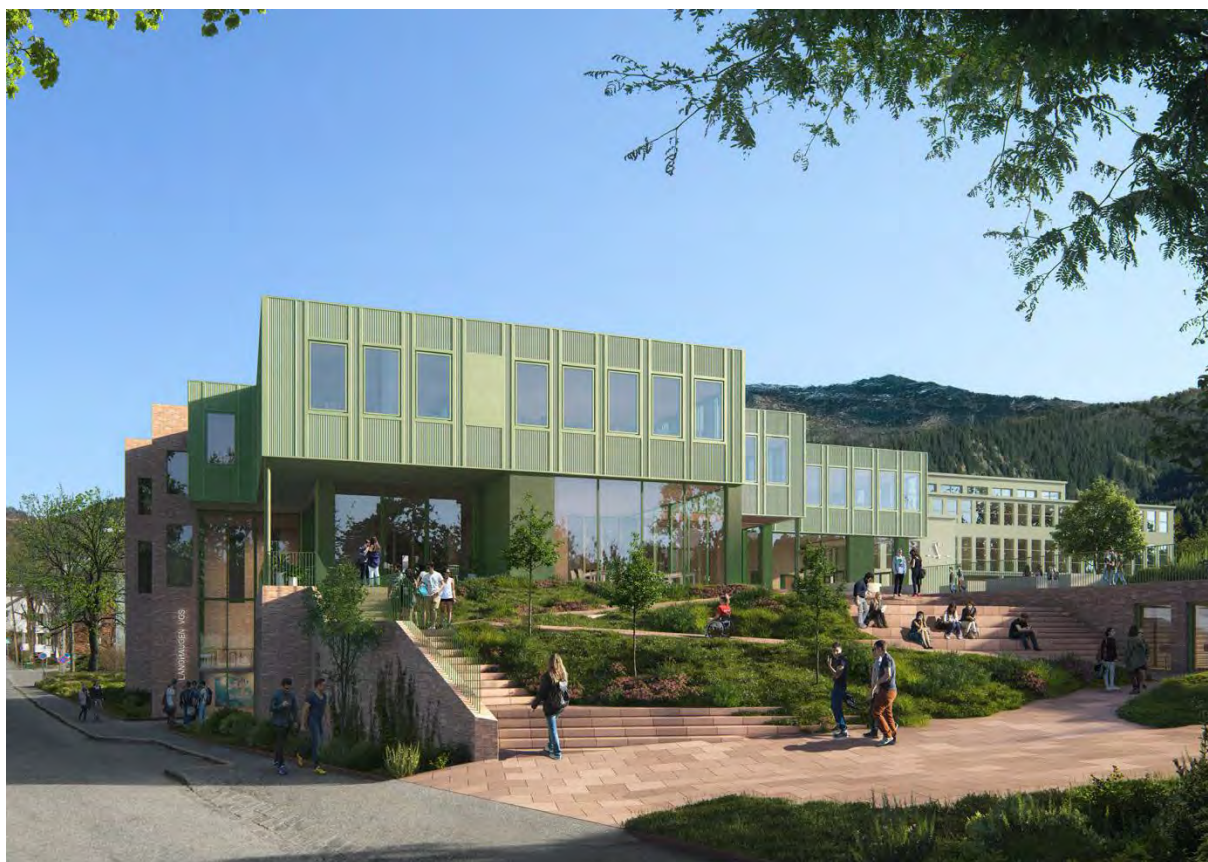
Figur 23 "Solbakken" knytter seg til Slettebakksveien og øvre skoleplass. Skolebygget er avtrappet for å åpne siktlinjer opp mot eksisterende skolebygg. Fasadene er i rødt tegl, lik boligbebyggelsen i Slettebakksveien, og grønn, slik som Langhaugen skole i dag. (ill: Ola Roald Arkitektur)
