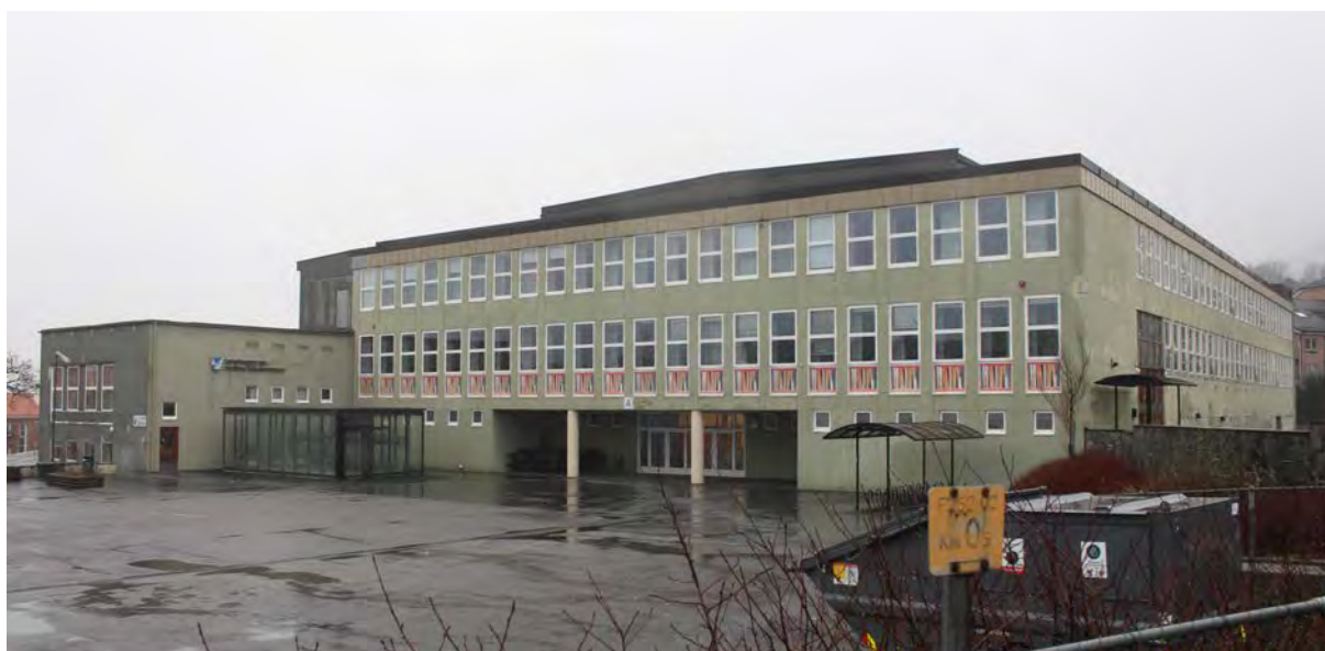
Figur 7 Skolen sett fra sør - dagens hovedinngang midt i fasaden (foto: ORA)
