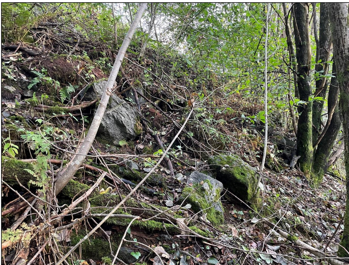
Figur 4. Skråning langs nordvestlige grense av kartleggingsområdet består av fyllmasser med blokker av varierende størrelse. Merk blokk med borppe i venstre del av bildet. Fyllmassene er dekket med tynt løsmassedekke og vegetasjon.
