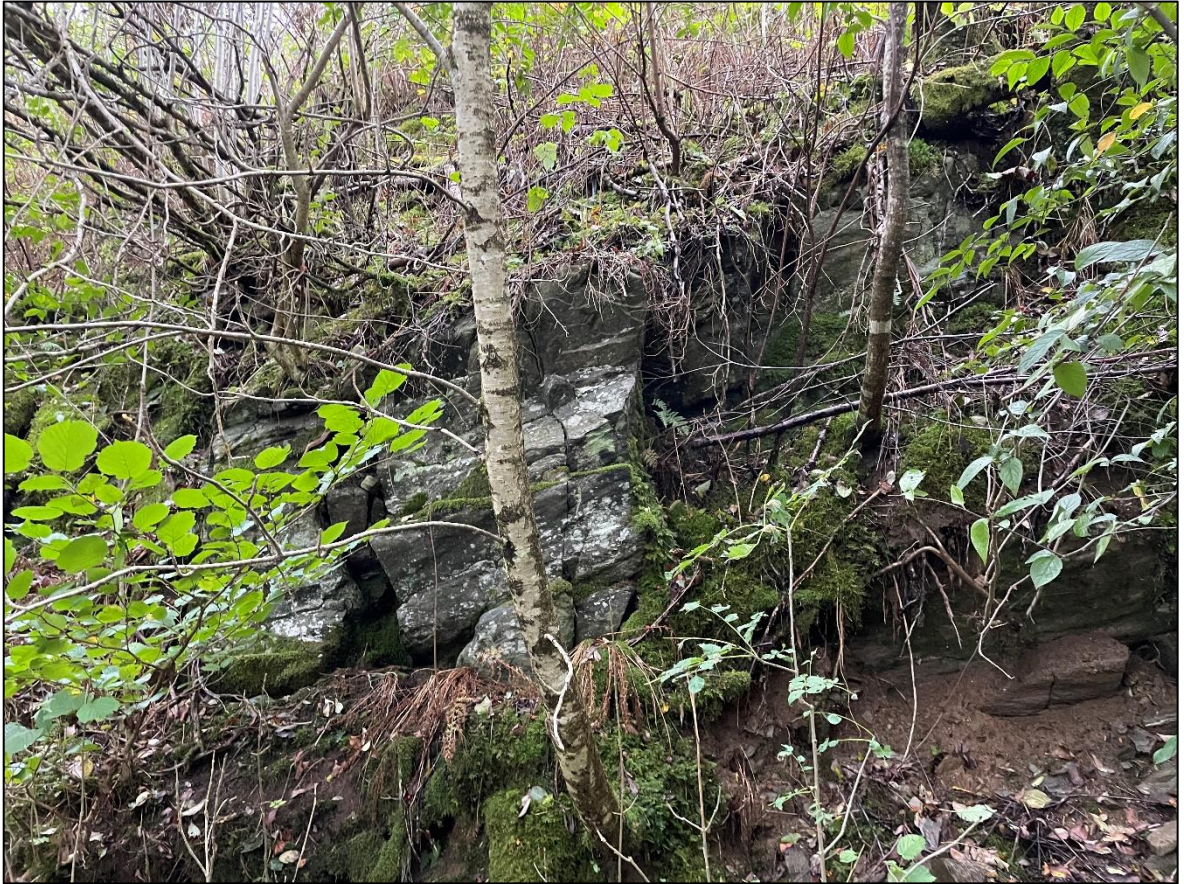
Figur 8. Blottet beg i sørvestlig del av påvirkningsområdet. I underkant av bergskrent ligger 2-3 m bredt platå/skogsvei over fyllmasser.
