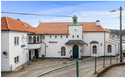
Figur 11: Eksisterende fasade mot nord og Østre Bellevuevei.
