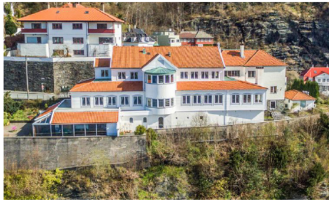
Figur 7: Bellevue slik bygningen fremstår i dag, sett mot nord.
