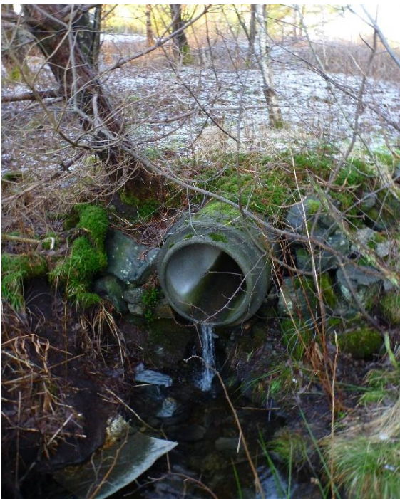
Figur 3-20. Bekk gjennom planområdet er lagt i rør. T.v.: øverste kulvert på ny sykehjemstomt. T.h.: vannføring i nedre kulvert.
