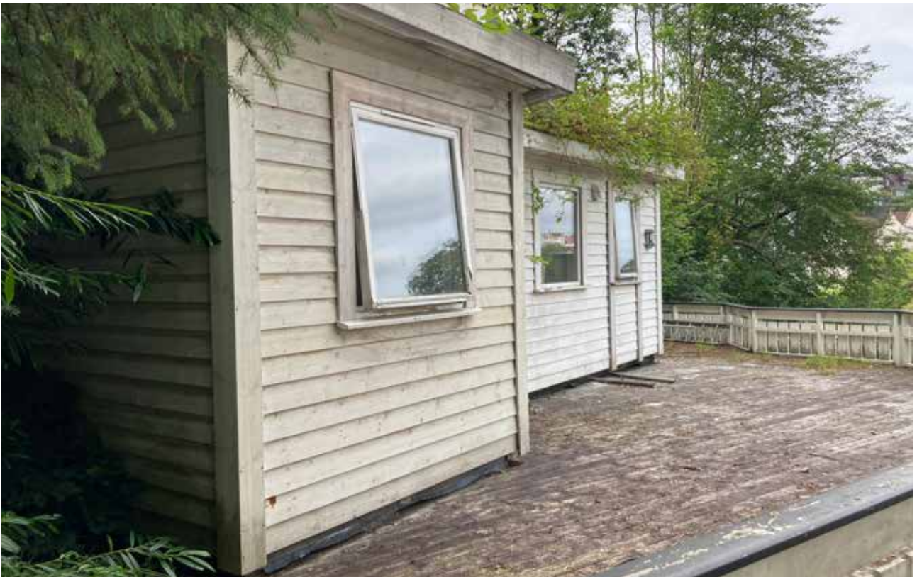
Tilbygg på terrasse (oppå garasje), like sør for bustaden.
