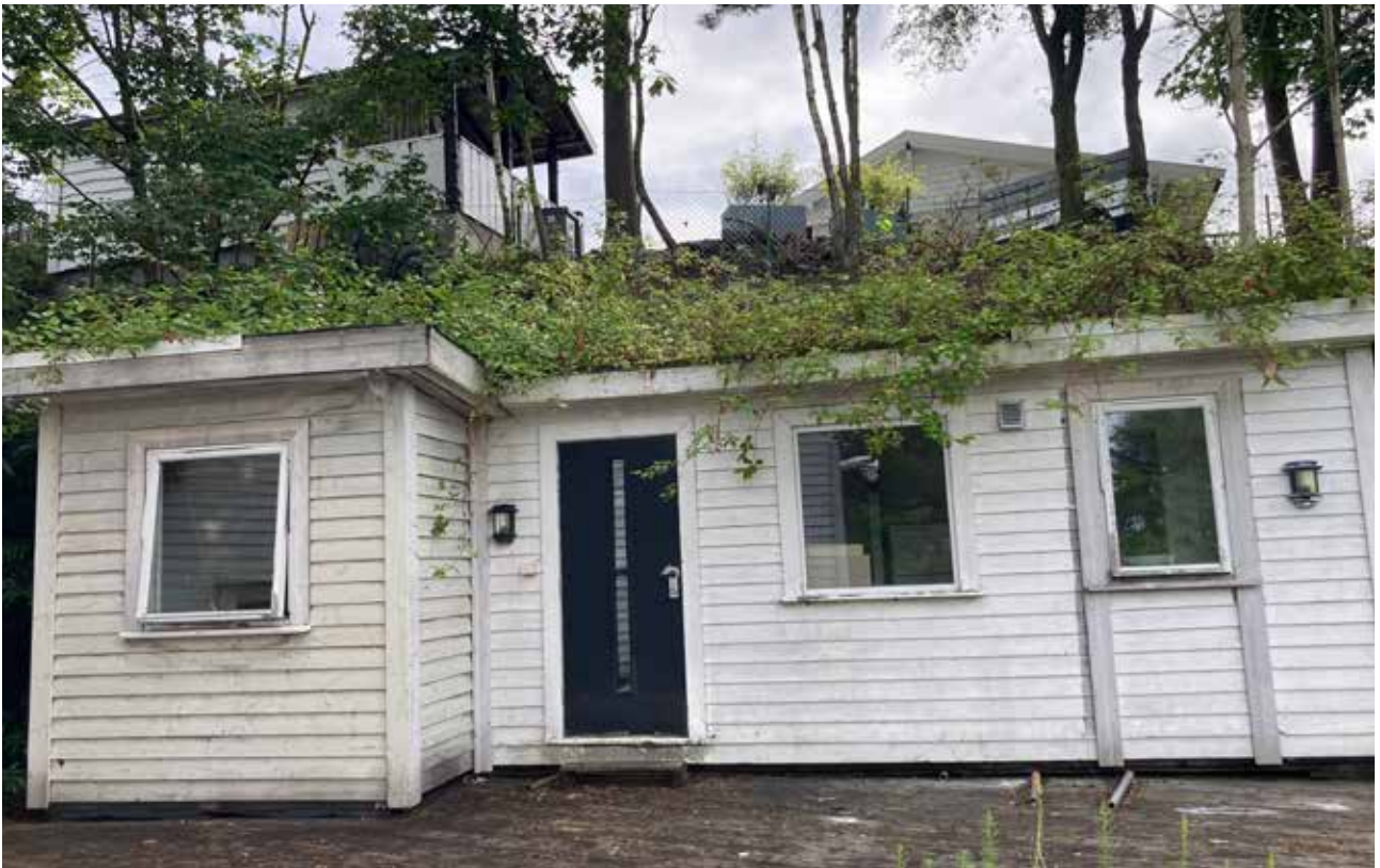
Dagens situasjon, detalj. Tilbygg oppgå garasjetak, ukjent byggeår.
