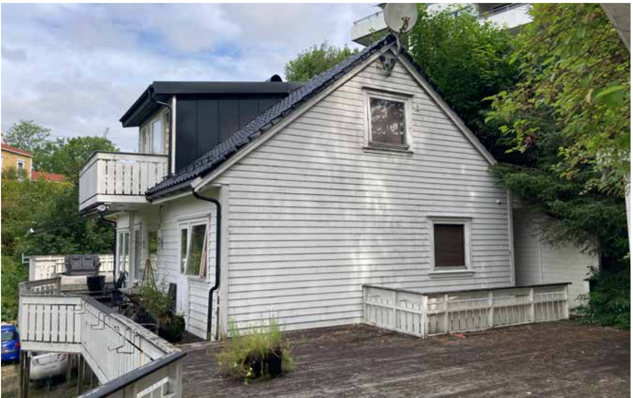
Dagens situasjon, fasadar mot sørvest og søraust. Bildet er tatt frå den store terrassen oppå garasjen.
