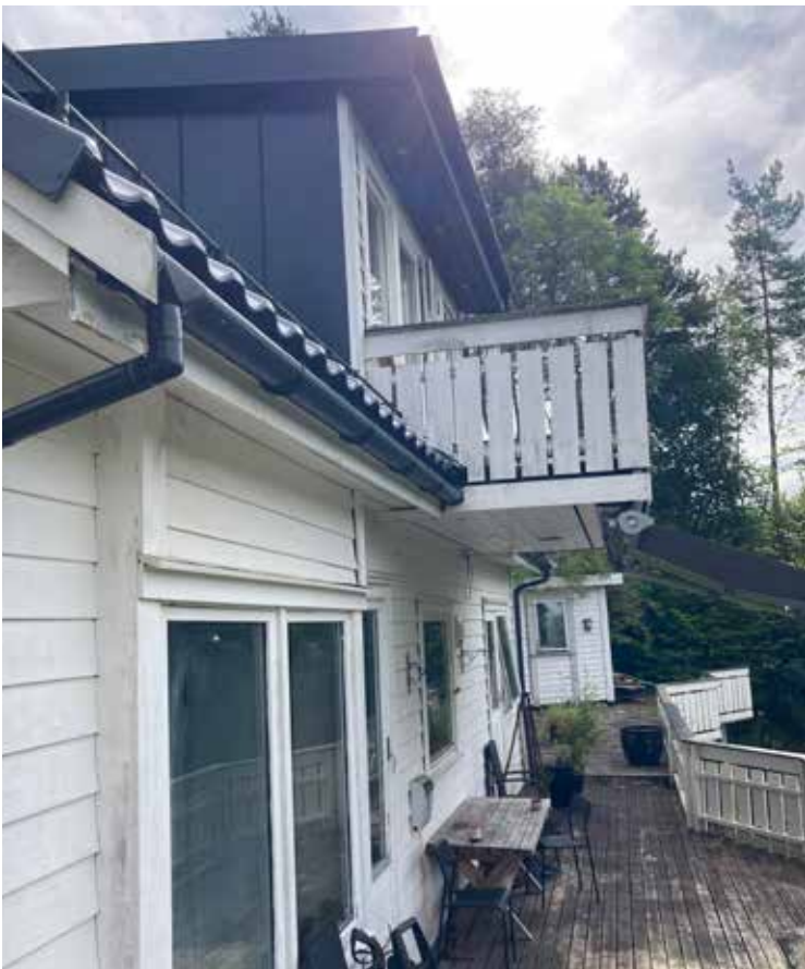
Dagens situasjon – detaljbilde av opplett og altan bygd ca. 2004.
