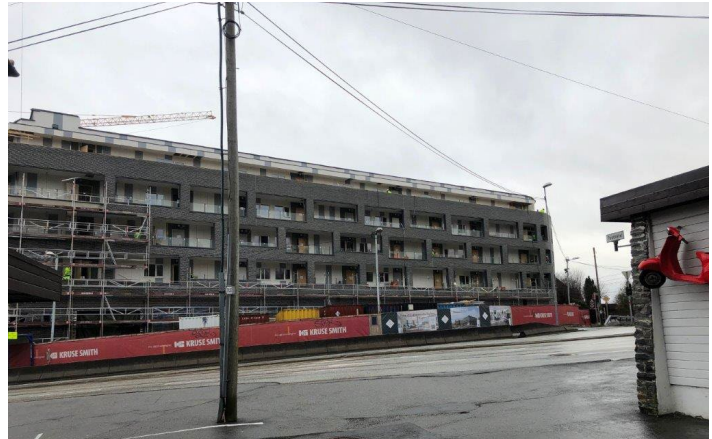
Figur 25 - Leilighetsbygg Paradis S5 under oppførelse. Foto LINK arkitektur.
