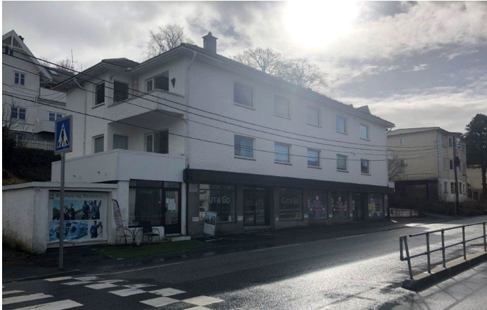
Figur 22 - Murgård med næringssetasje vis-a-vis Paradis skole. Foto LINK arkitektur.
