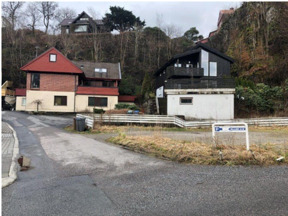
Figur 24 - Småhusbebyggelse. Foto LINK arkitektur.
