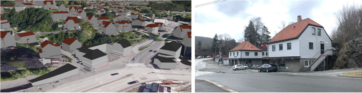
Figur 3-3 Til venstre: modell som viser eksisterende bebyggelse og terreng i og rundt planområdet, kilde: kommune kart 3d. Til høyre: Foto av eksisterende bebyggelse i planområdet, kilde: Link arkitektur.
