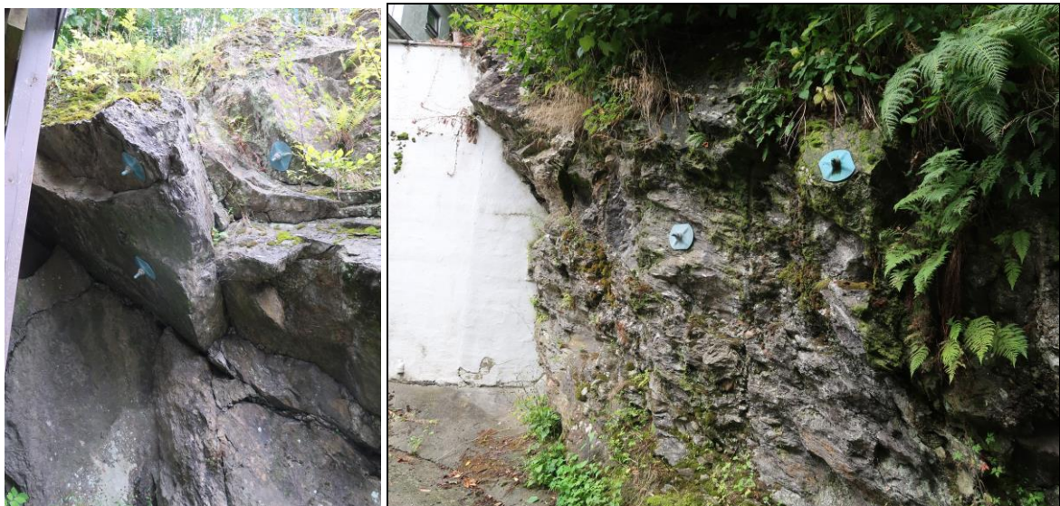
Figur 5. Boltesikring av skjæring bak Paradisleitet 1.
