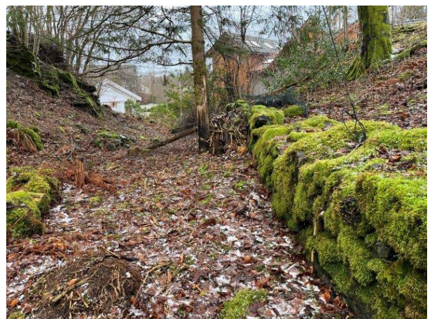
Figur 41 - Tørrsteinsmur i søkk nord for eiendommen.
