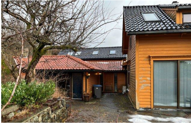
Figur 36 - Tilbygg fra 1950 og 2002.
