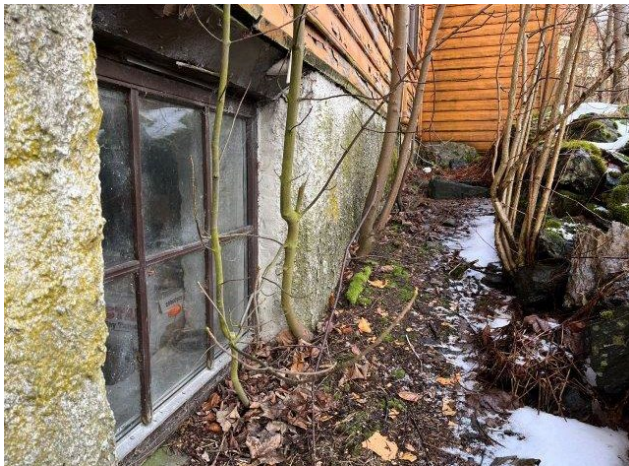
Figur 38 - Grunnmur mot øst.
