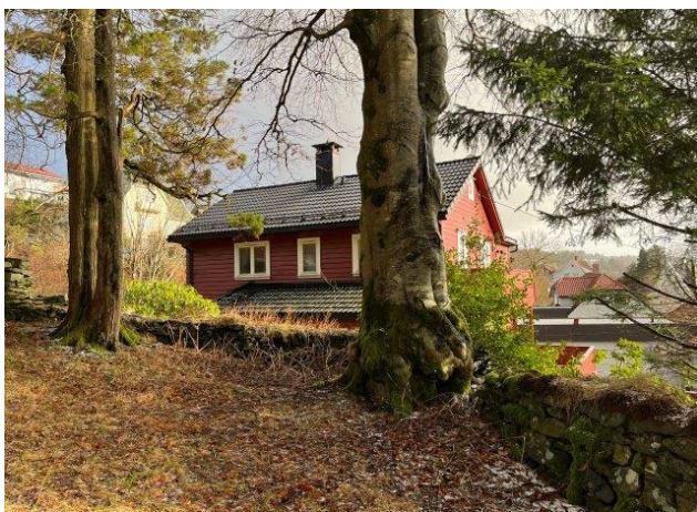
Figur 40 - Tørrsteinsmur mot nabo i øst.
