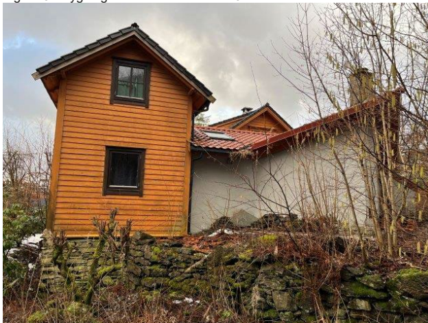
Figur 21 - Bygning sett fra nord.
