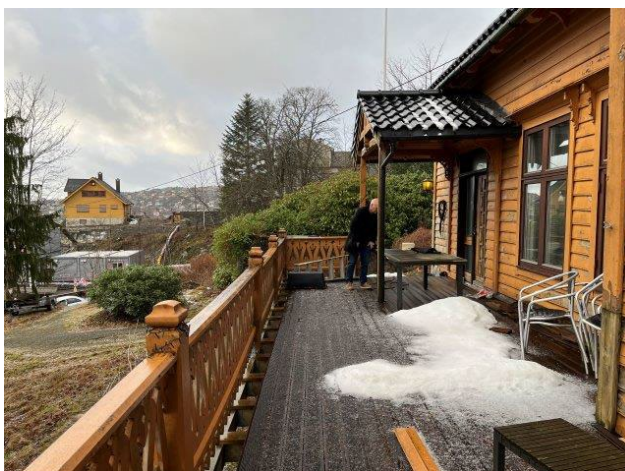
Figur 34 - Nyere terrasse og inngangsdør.
