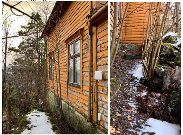
Figur 22 - Fasade mot øst.
