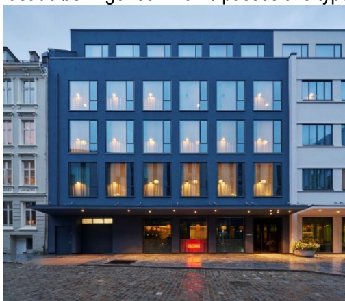
Pusset fasadeløsning på Zander K hotel i Bergen sentrum. Det er her benyttet Weber fasadepuss system. Se detalj av veggoppbygning over.
