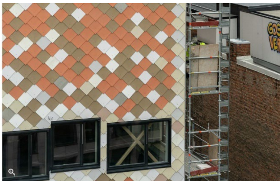
Gjenbruk av gamle fasadeplater fra Steni
