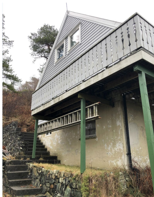
Figur 5-4 Boligen sett mot nordøst. Altan og oppmurt trapp.
