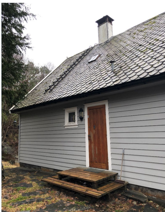
Figur 5-3 Inngangsdør og enkel trapp på nordsiden av boligen. Taket er tekket med skifer.
