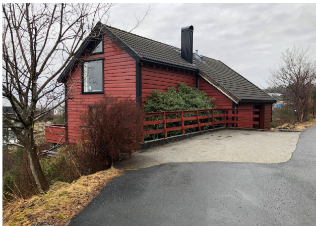
Figur 5-9 Boligen sett mot nordvest.
