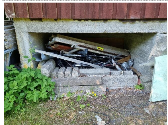
Bilde nr. 2.10 Garasjens grunn og fundament, innhukk har vært i bruk når garasjen ble benyttet som stall.
