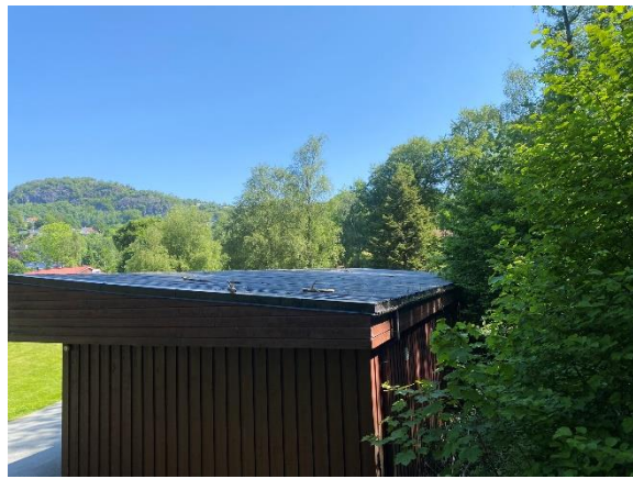
Bilde nr. 2.23 Garasjens vestside. Yttervegg med stående trekledning.
