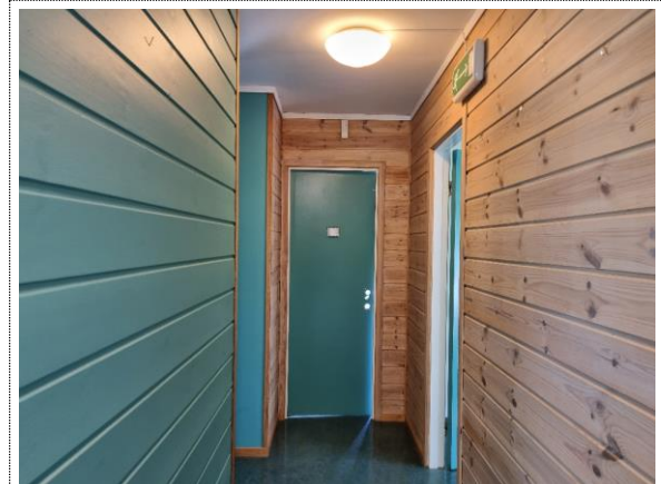
Bilde nr. 2.36 Bygg 4 Innervegger av trepanel med ulik behandling. Antar at innervegger i bygg 6 er tilsvarende som på bildet.
