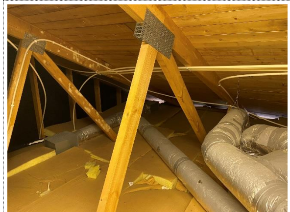
Bilde nr. 2.54 Bygg 4 Antatt lik oppbygning på bygg 6. Synlig vindsperre på gavlvegg. Innertak i liggende trepanel.
