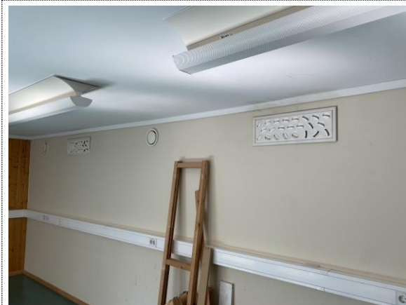
Bilde nr. 2.35 Bygg 4 Innervegger av gips med slett overflate. Antar at innervegger i bygg 6 er tilsvarende som på bildet.
