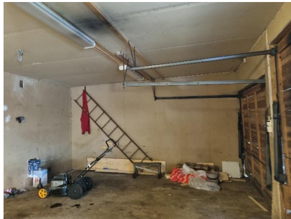
Bilde nr. 2.39 Garasjens innervegger av gips.
