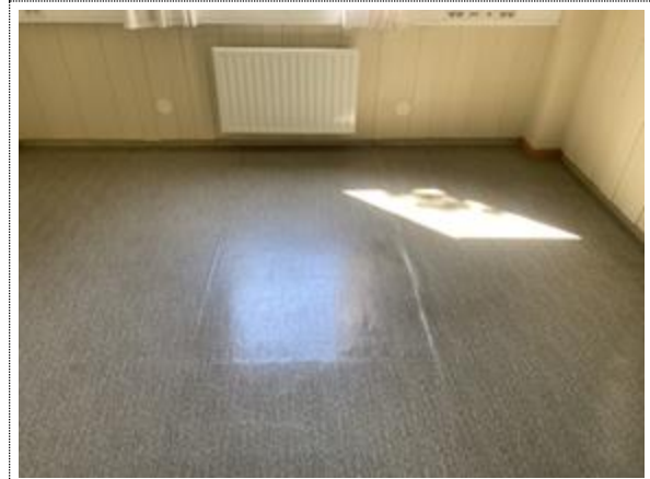
Bilde nr. 2.46 Bygg 4 Antar at gulvoverflate i bygg 6 er tilsvarende. Gulvoverflate av banebelegg.
