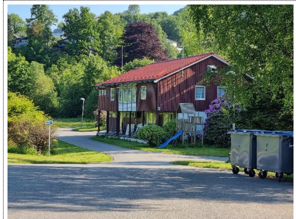
Bilde nr. 7.01 Utendørs rundt bygg 6.
