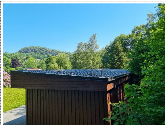
Bilde nr. 2.55 Garasjens yttertak med tekning av bølgeblekk.
