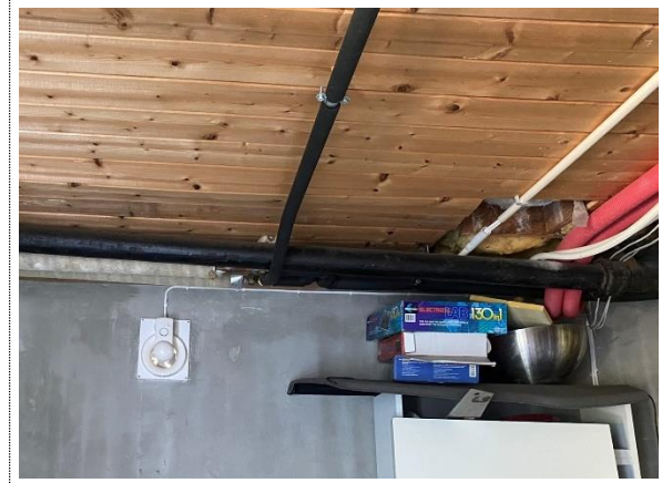
Bilde nr. 2.42 Åpning i himlingen i sportsbod. Observerer at bjelkelaget er isolert.
