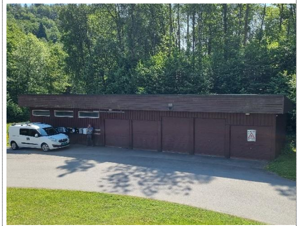
Bilde nr. 2.22 Oversiktsbilde av garasjen. Yttervegger av stående kledning i treverk.
