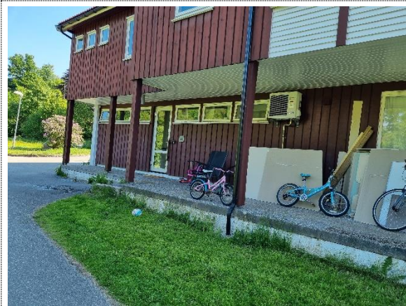
Bilde nr. 2.45 Nærmere bilde av utkragende del ved bygg 6.
