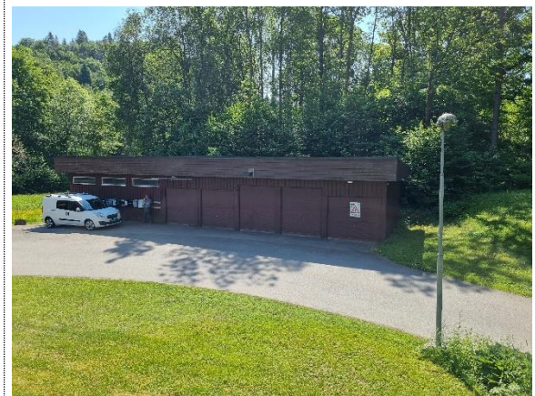
Bilde nr. 2.08 Oversiktsbilde over garasjen.
