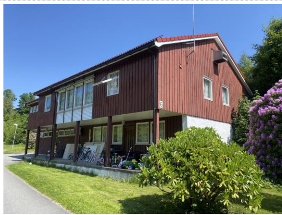
Bilde nr. 2.01 Oversiktsbilde av bygg 6 sett fra sør-vest.
