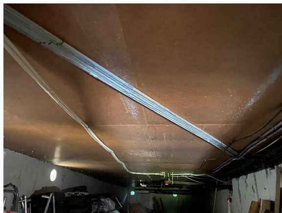
Bilde nr. 2.49 Himling av trefiberplater i krypkjeller.
