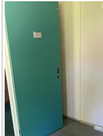
Bilde nr. 2.40 Bygg 4 Laminert innerdør. Antar at innerdører i bygg 6 er tilsvarende som på bildet.
