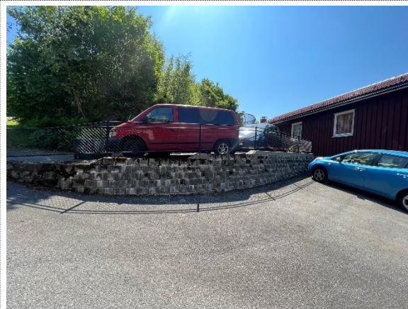
Bilde nr. 7.04 Støttemur på østsiden av bygg 6.
