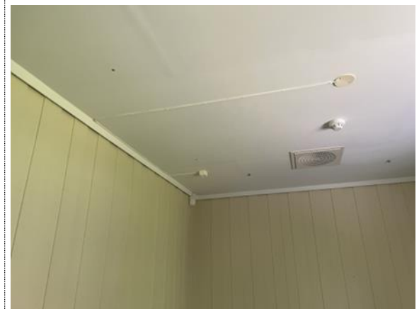
Bilde nr. 2.50 Bygg 4 Himling av gipsplater. Antar at himling i bygg 6 er tilsvarende som på bildet.
