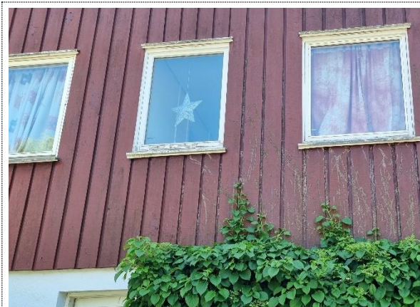
Bilde nr. 2.33 Solavskjerming i form av gardiner
