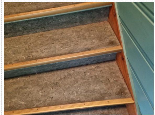
Bilde nr. 2.60 Bygg 4 Innvendig trapp. Antar at innvendig trapp i bygg 6 er tilsvarende.
