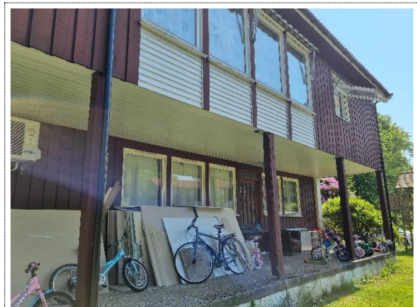
Bilde nr. 2.56 Nedløp fra takrenne på bygg 6.
