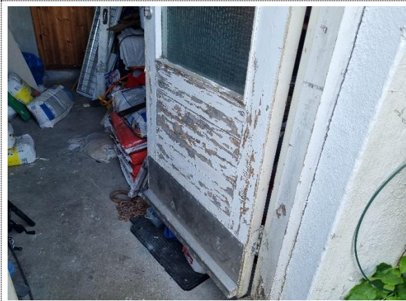
Bilde nr. 2.29 Nærbilde av ytterdør til sportsbod i byggets U.etg.
