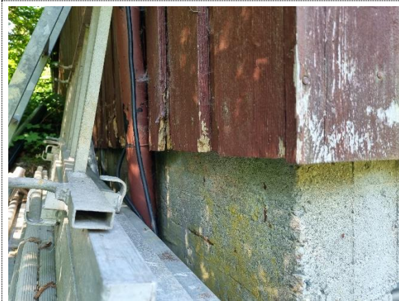
Bilde nr. 2.09 Garasjens grunn og fundament. Hjørnet på ringmur.
