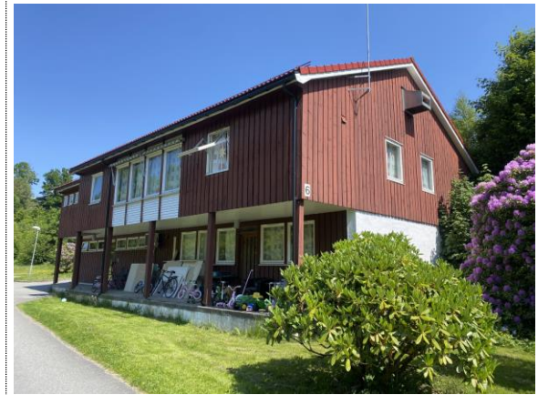
Bilde nr. 2.12 Byggets bæresystem. Yttervegger i betong og søyler i treverk.
