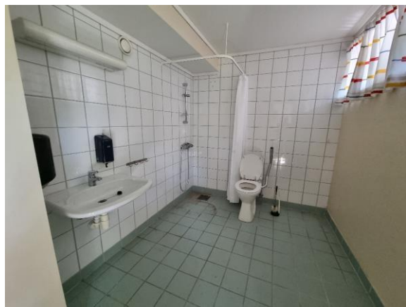
Bilde nr. 2.37 Bygg 4 Fliser på baderomsvegger. Antar at baderom i bygg 6 er tilsvarende som på bildet.
