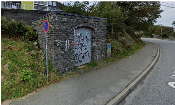
Figur 110: Trafobygning i Gyldenprisvegen, kilde google kart.
