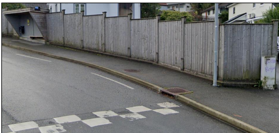
Figur 101: Eksisterende kjeftsluk i Fyllingsveien. Kilde google kart.
