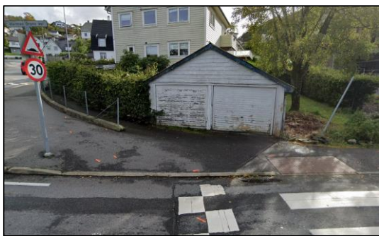
Figur 13: Eldre garasje som må rives i dette alternativet
