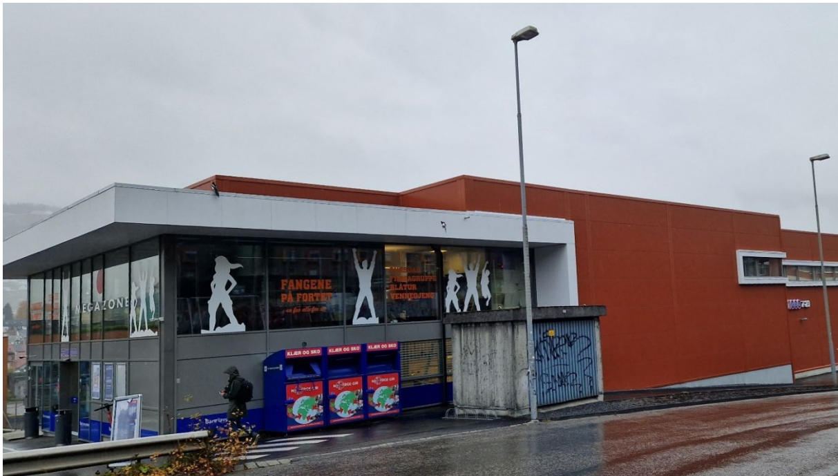
Figur 26: Nettstasjon i nordlige del av Gyldenprisveien.
