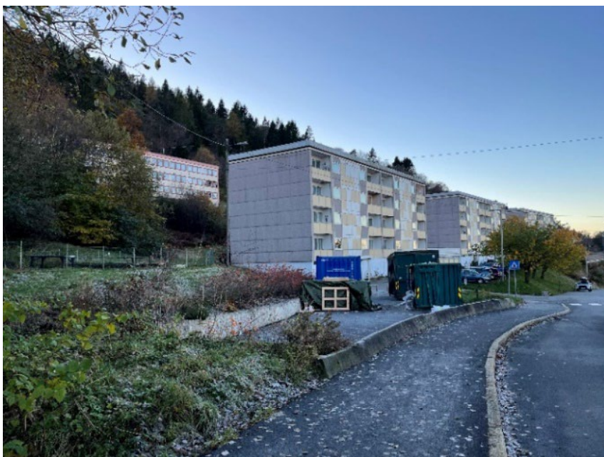
Figur 53: Bildet viser grøntarealet og parkeringsplassen i tilknytning til Gyldenprisveien 49, som vurderes som midlertidig bygge- og anleggsområde. Foto: Norconsult, oktober 2023.
