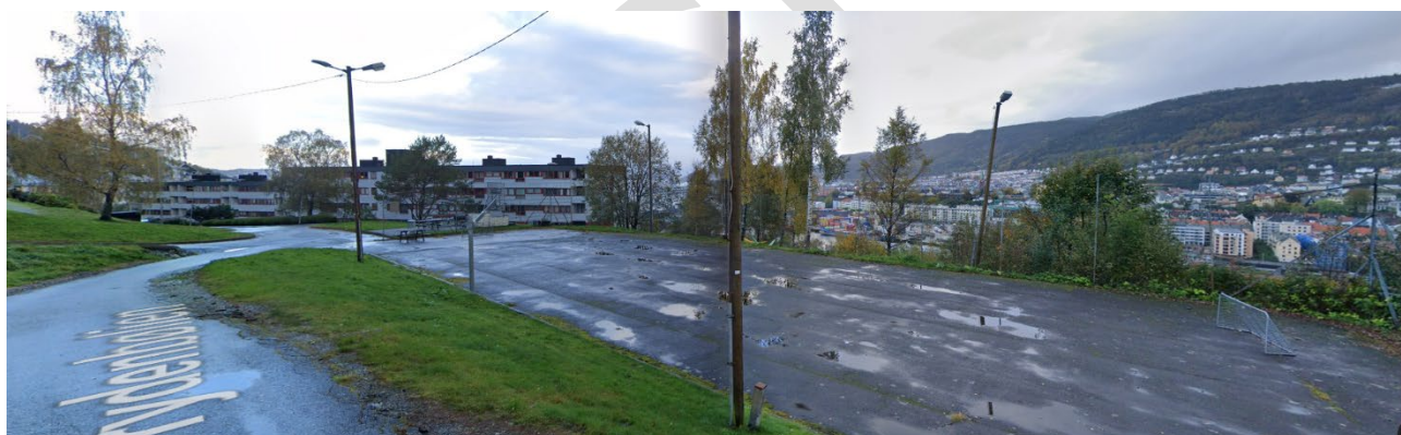
Figur 54: Utsnittet viser banen og grøntområdet ved Frydenbølien som vurderes som midlertidig bygge- og anleggsområde. Bildet er hentet fra Google Street View og er fra oktober 2022.
