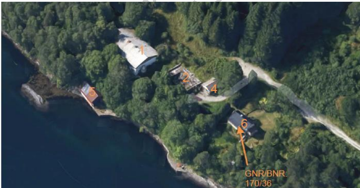
Figur 3-9: Område for ny kai. Bygg nr. 1-5 står på forslagsstillers eiendom, gnr/bnr. 170/75. Bygg nr. 6 er hytte / fritidseiendom på gnr/bnr. 170/36. Fremtidig tunellportal mellom bygg 1 og 2. Kilde: Bildet er hentet fra planbeskrivelsen til gjeldende plan (Asplan Viak).
