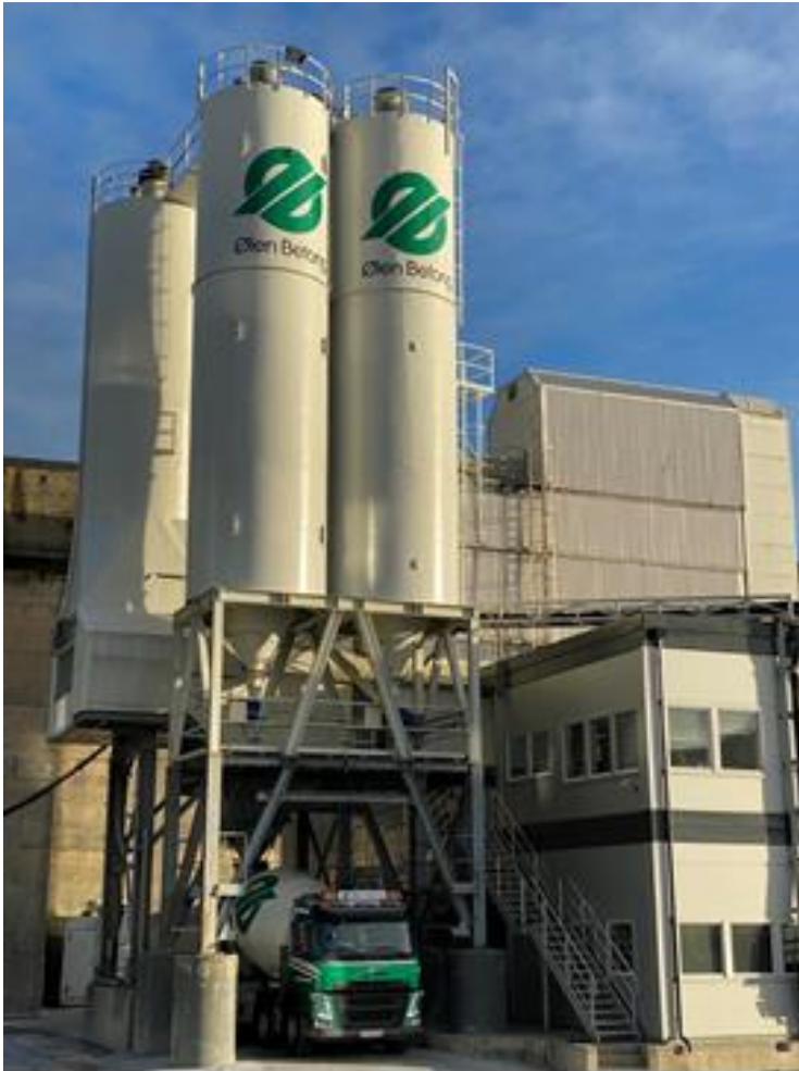
Figur 5-11 Eksempel på del av et betongverk, her fra betongverk i Laksevåg. Kilde: Ølen betong.
