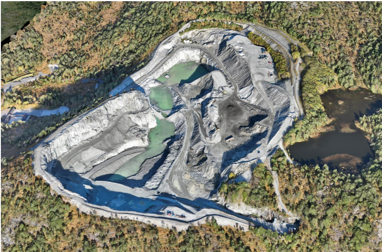
Figur 3-4 Dronebilde av pågående steinbrudd. Det er etablert anleggsvei i den ytre sonen av anleggsområdet. Foto: NCC Industry AS
