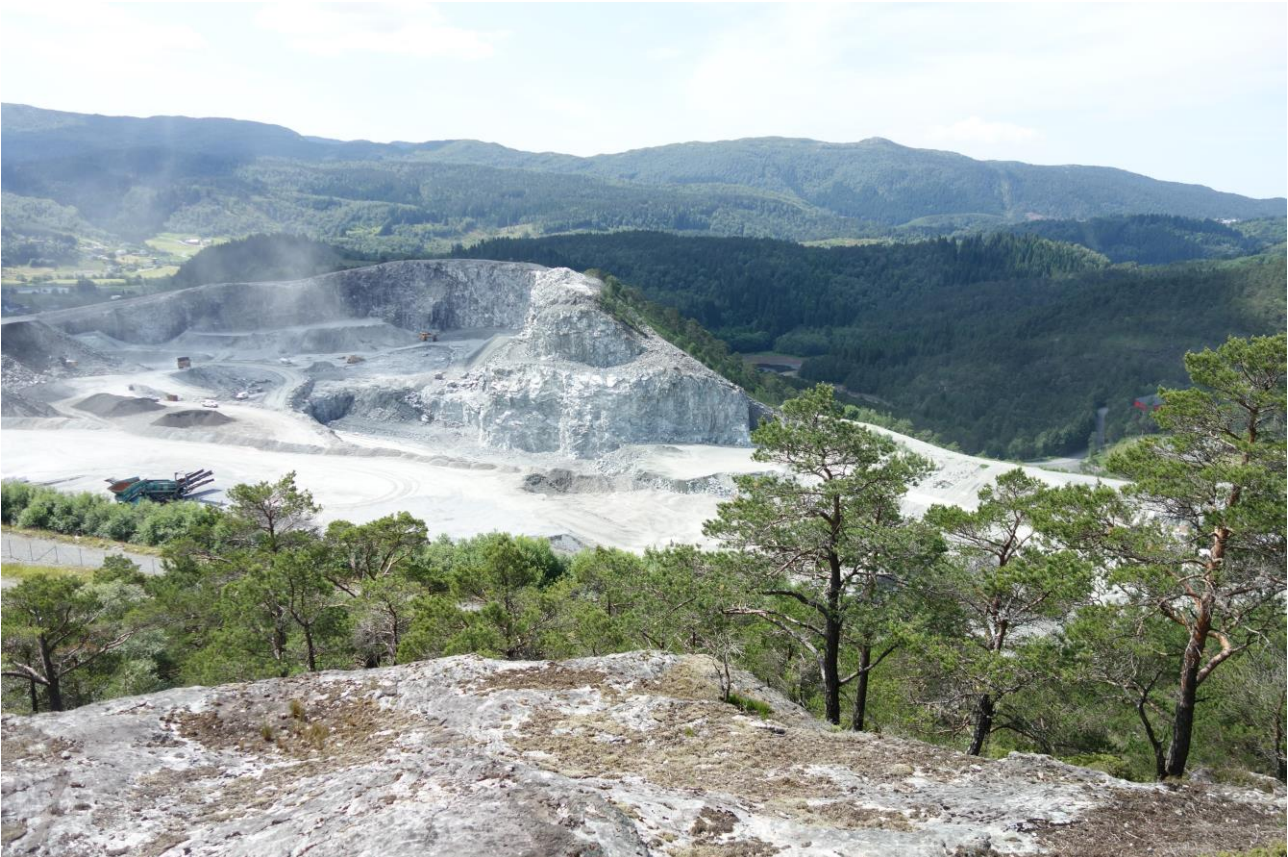
Figur 3-2 Steinknuseverket sett mot sørvest.
