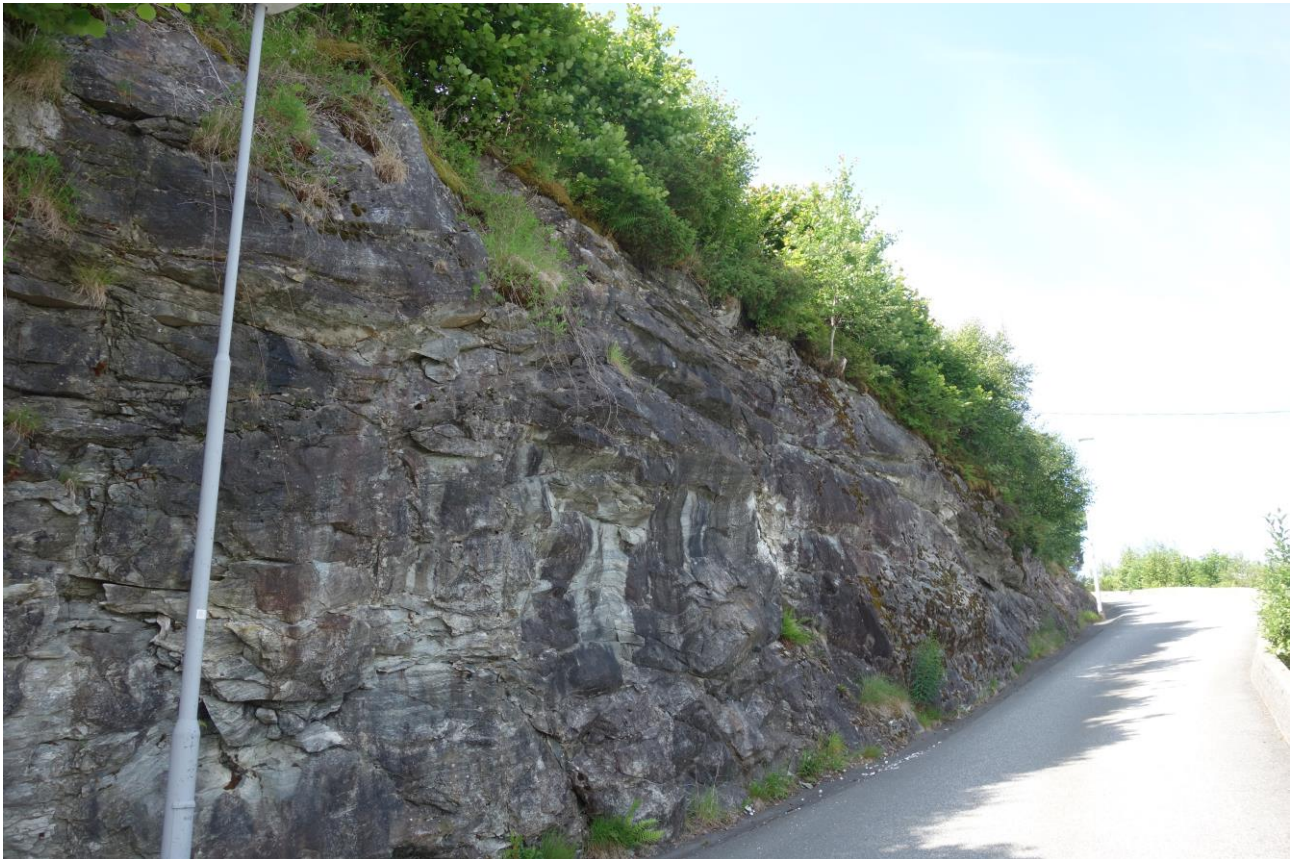
Figur 8. Tolket anortositt ved innkjørsel til Plytten fra Sørfjordvegen i Ytre Arna.
