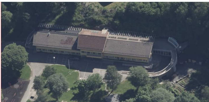
Figur 6: Dagens hovedbygg, grunnskolen. Rampe til høyre. Skråfoto.
