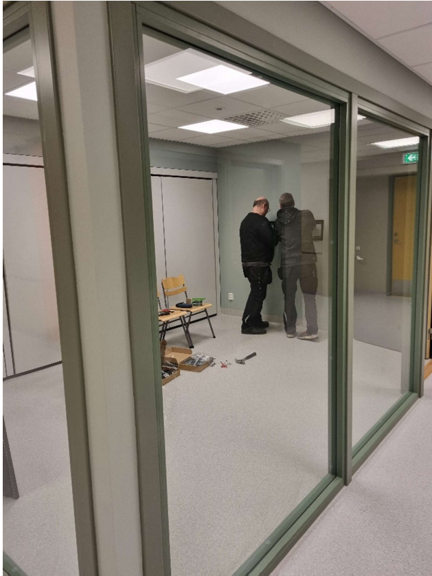
Nye grupperom med glassvegger, montering av digital tavle
