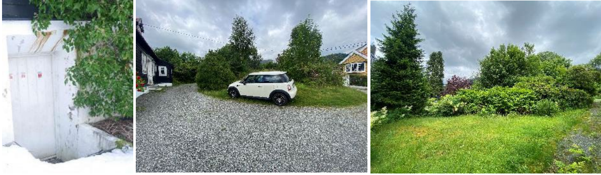
Figur 4-21 Tv.: Muren ved kjellerdøren på husets nordre fasade bærer preg av fuktskader. Midten: Kollen mellom Wergelandsbakken og boligen er intakt med gamle hagevekster og to nyere bjørketrær. Th.: Hagen mot nord er overgrodd (gnr. 13/69).
