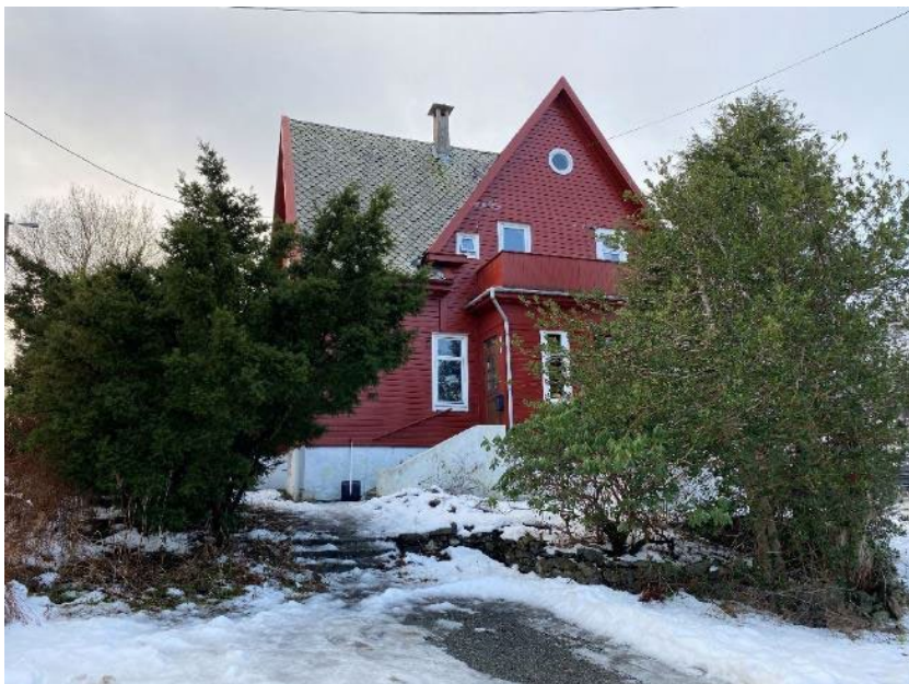
Figur 4-13 Wergelandsbakken 1 (gnr. 13/182), sett mot sør.
