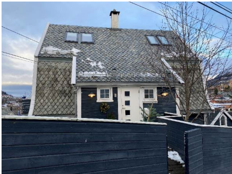
Figur 4-11 Fageråsveien 7 (gnr. 13/203), sett mot nord.
