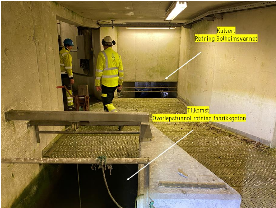
Figur 1 Bilde fra innsiden av inntakskonstruksjonen. Nederst på bildet ser man tilkomsten til overløpstunnelen i nord og øverst på bildet er overgangen til kulvert som kommer fra sør. Inngang mot avløpstunnelen ligger til høyre for bildet.
