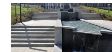
Trapper og vannanlegg mot parken
