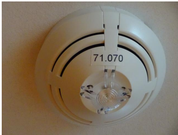
Merking av detektor nummer 70 på sløyfe 71.
