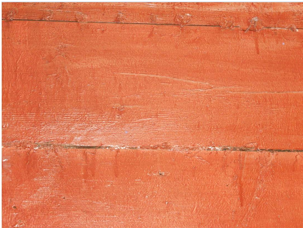
Figur 9: Detalj av maskinlaft fra et av lekerommene. At det er maskinlaft, og altså trolig ikke fra 1700-tallet, ser vi på sammenføyningene mellom to omfar. Sammenføyningene er ikke er tilpasset/tilhugget med øks, noe som var vanlig på skåret plank i Bergen på 1700-tallet. Hvis dette hadde vært skåret 1700-tallsplank som var hugget til, ville man sett en tilpassing inn mot meddraget (der hvor stakkene ligger oppå hverandre) (Foto: Byantikvaren 2015).
