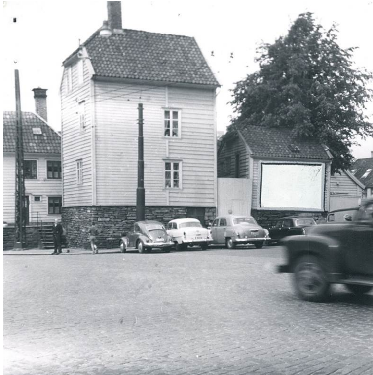
Figur 6. Bilde av Kalmargaten 2 i 1960. Det revne uthuset ses til høyre i bildet. Det var søkt om å bruke uthusets vegg som reklamevegg. Søknaden ble avslått (Kilde: Byggesaksarkivet).
