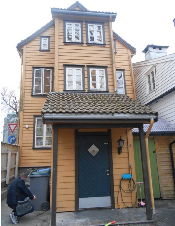
Figur 12. Husets egentlige hovedfasade, mot den tidligere Kalmarhagen, er estetisk og antikvarisk svekket av dette uheldige tilbygget fra 1992 (Foto: Byantikvaren 2015).
