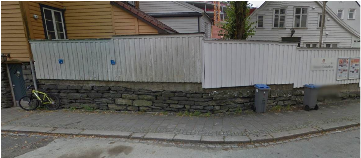
Figur 22. Tørrsteinsmur langs «hagen». (Foto: Google maps).
