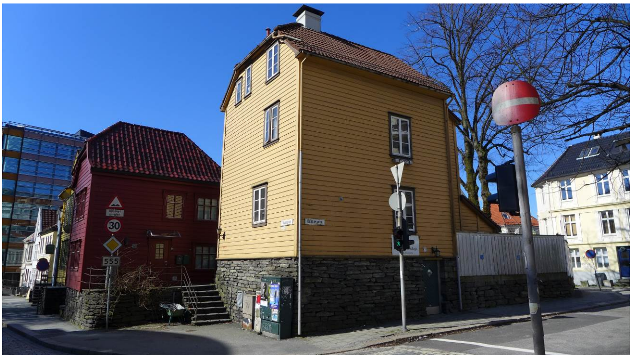
Figur 13. Disse fasadene, som i dag er de mest eksponerte, sto opprinnelig vegg i vegg med bygninger som er revet i ettertid. Dette er nok forklaringen på den noe tilfeldige vindusplasseringen (Foto: Byantikvaren 2015).
