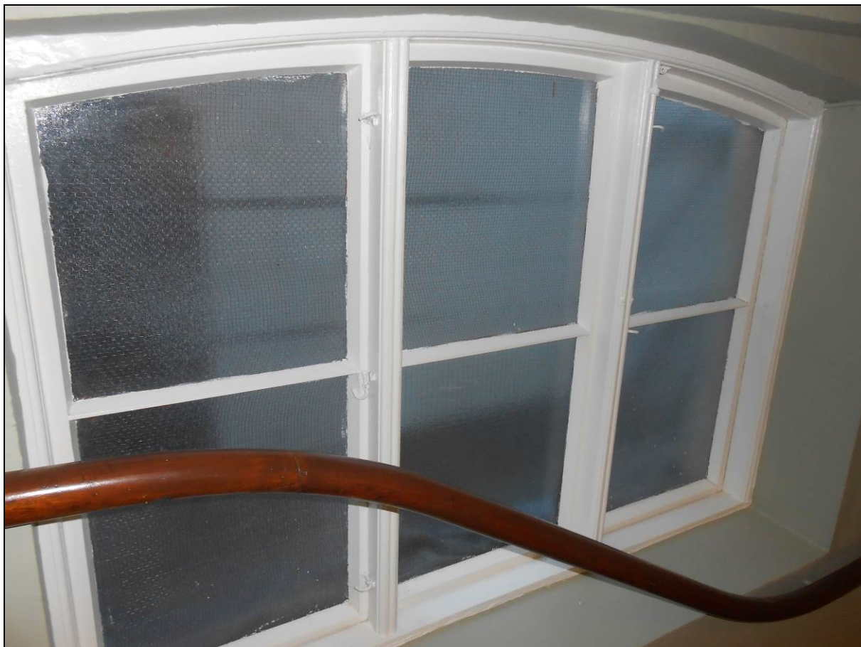
Figur 14. Gamle trådglassvindu i trapperommet (Foto: Byantikvaren 2015).
