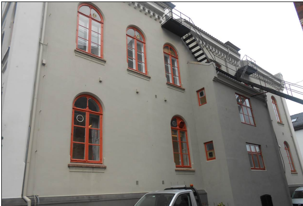
Figur 9. Bakfasaden inn mot fengselsbygningen i sørvest har en enklere, ikke-monumental utforming. Forbindelsestrappen over til fengselet er fra 1932/33 (Foto: Byantikvaren 2015).
