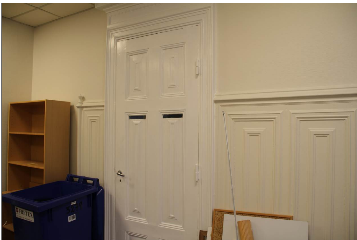
Figur 17. Morsom detalj: Dør i annen etasje med smale, innfelte glasspalter som må ha vært ment for observasjon/overvåking. Profilerte brystningspaneler på sidene (Foto: Byantikvaren 2015).
