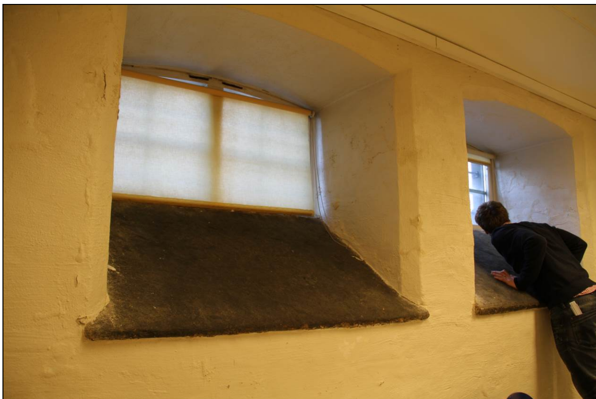
Figur 11. Dype og bratte vindusbenker forsterket med solide skiferheller i kjelleren (Foto: Byantikvaren 2015).
