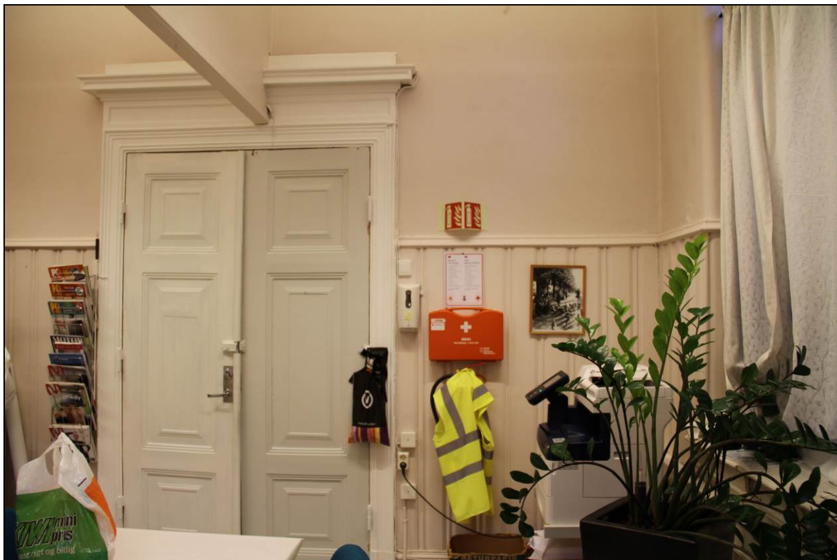
Figur 16. På tross av nyere tilføyelser og endret rominndeling, er dørene med sin rike profilering og omramming i høy grad bevart (Foto: Byantikvaren 2015).
