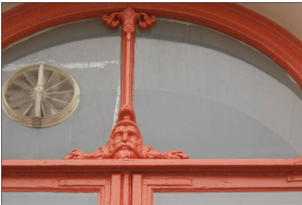
Figur 6. Vindussprosser i støpejern med ansiktsmasker (Foto: Byantikvaren 2015).
