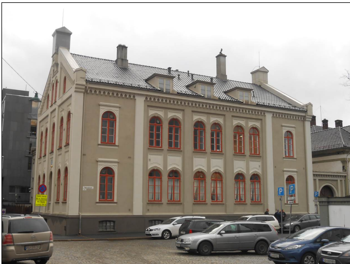
Figur 5. Hovedfasaden mot nordøst. Vertikale fasadebånd og rekkene med buede vindu preger uttrykket. Alle vinduene i denne fasaden er originale. De tre takopplettene kom til i 1932/33 (Foto: Byantikvaren 2015).
