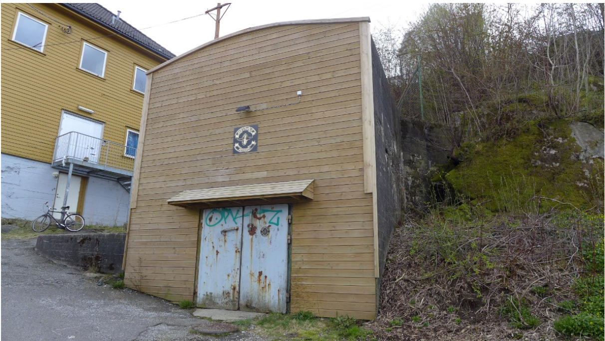
Figur 21. På nordsiden av bygningen er det en tilkomst til et større dekningsrom i fjellet. Anlegget tilhørte den tyske mannskapsleiren og blir i dag benyttet av en motorsykelklubb. Fasaden til bunkeren har nylig blitt kledd inne med trepanel (Foto: Byantikvaren 2015).
