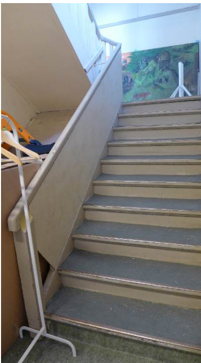
Figur 17. Trapperom med opprinnelig trapp og rekkverk i sørenden av bygget (Foto: Byantikvaren 2015).
