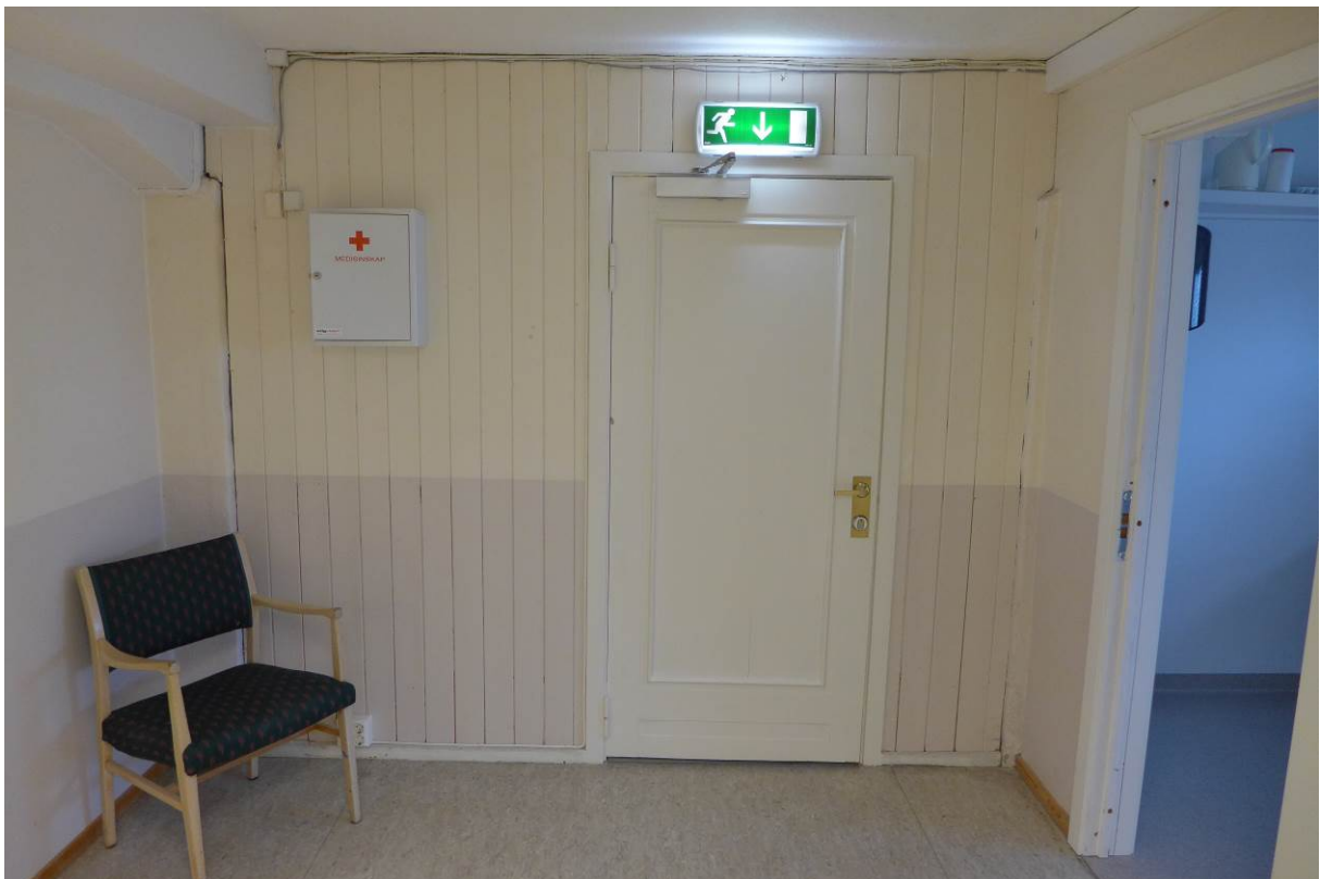
Figur 16. Sannsynligvis opprinnelig trepanel i kjelleretasjen (Foto: Bergen kommune, Byantikvaren 2015).
