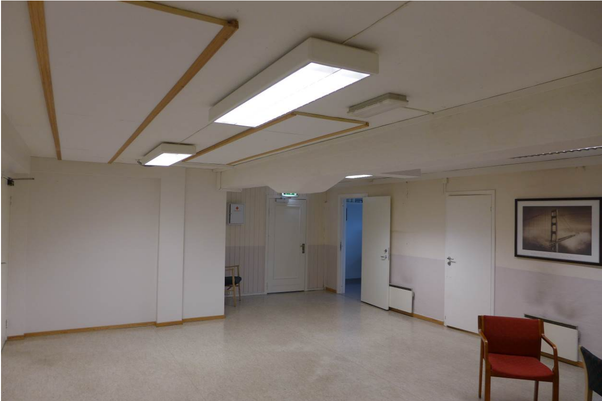
Figur 17. Flere nyere overflater i kjeller. Svært kraftige takbjelker av betong (Foto: Bergen kommune, Byantikvaren 2015).
