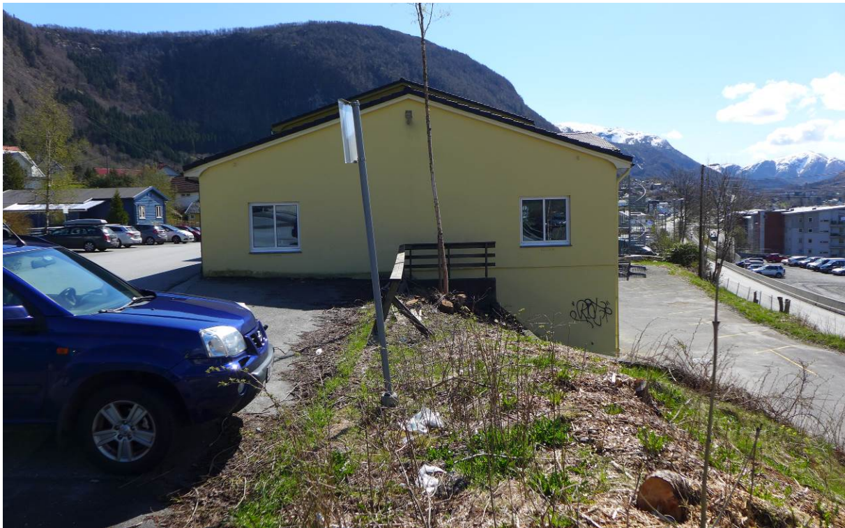
Figur 20: Uteområde nord for bygningen (Foto: Bergen kommune, Byantikvaren 2015).
