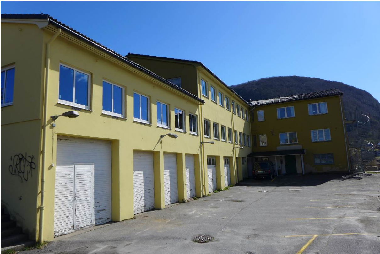
Figur 5. Bygningen fotografert mot sør. Tilbyggene fra 1970 og 1965 ligger nærmest i bildet (Kilde: Byantikvaren, Bergen kommune 2015).
