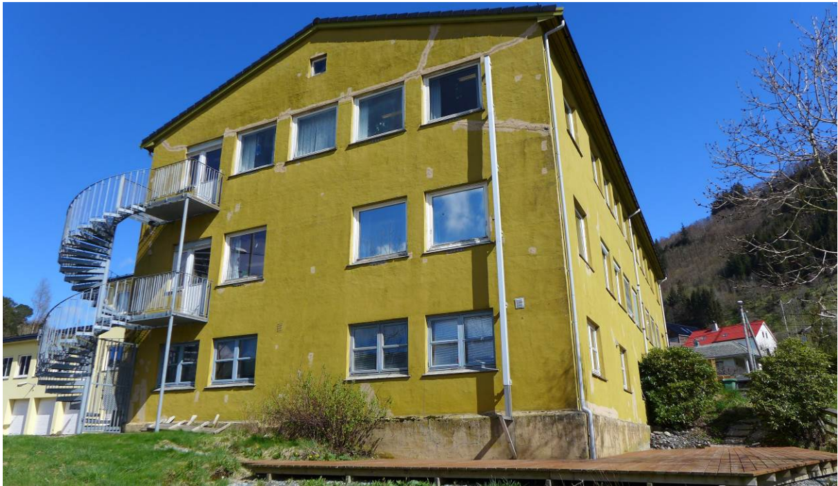
Figur 6. Fasade mot vest. Stort sett er uttrykket intakt, men rømningstrappen med dører er nye. Dørene er satt inn i utvidete, opprinnelige vindusåpninger (Foto: Bergen kommune, Byantikvaren 2015).
