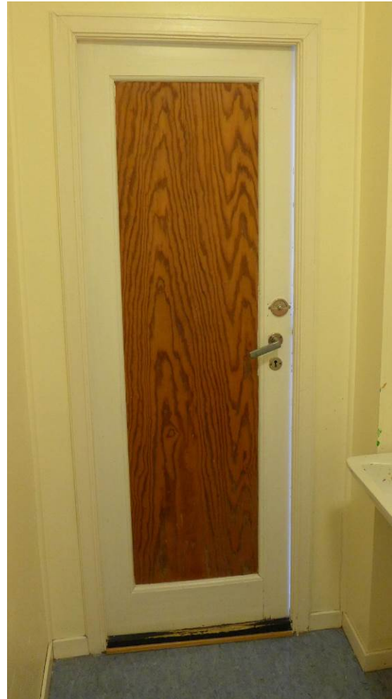
Figur 12. Gammel dør til toalett i andre etasje (Foto: Bergen kommune, Byantikvaren 2015).
