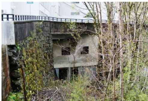
Det er et åpent rom under Gaupåsvegen langs elva.
