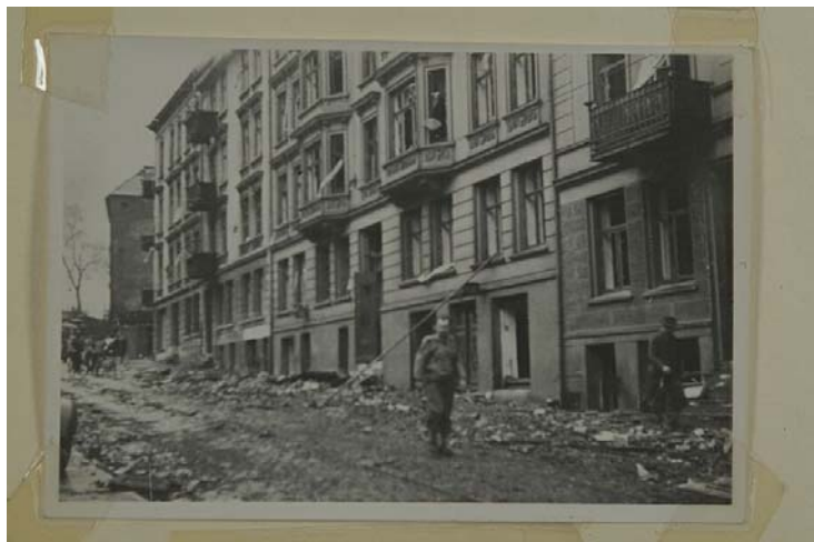
Ødeleggelsene i Nye Sandviksvei. Foto: ukjent. BBA-1181, Va:5.
