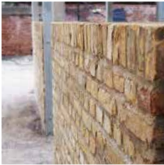
Eksisterende tegl renses og monteres
