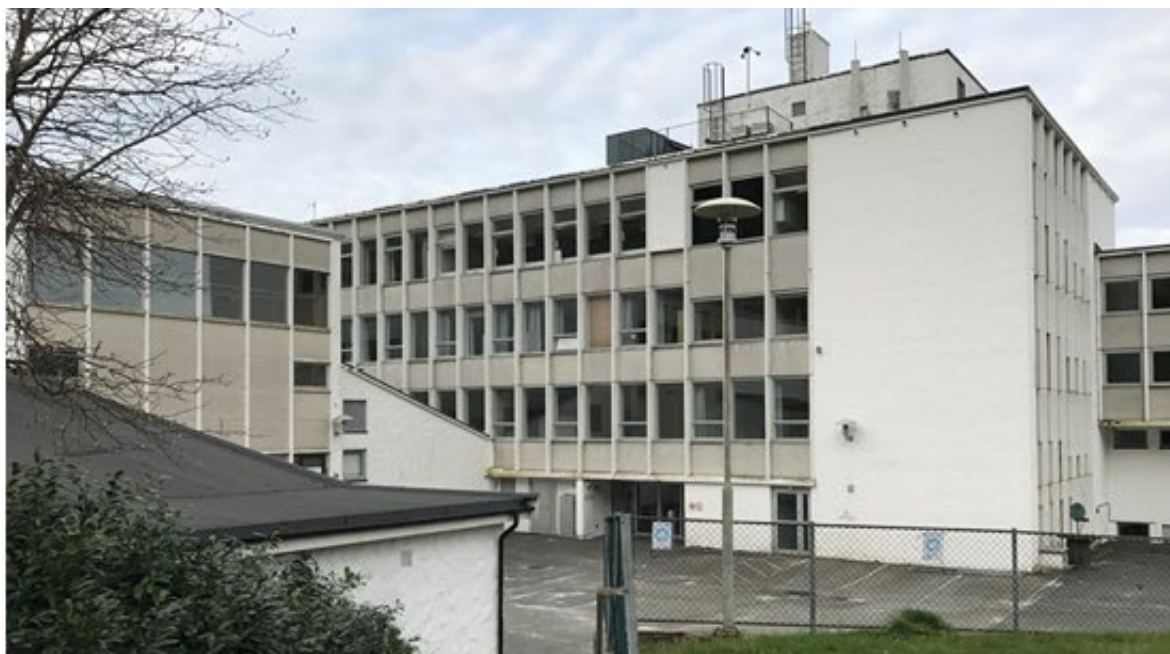
Eksisterende fasade bygg D
