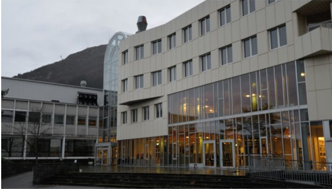
Eksisterende fasade bygg A
