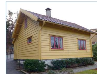
Figur: Kårbygning fra 1888, Nebbestølen
