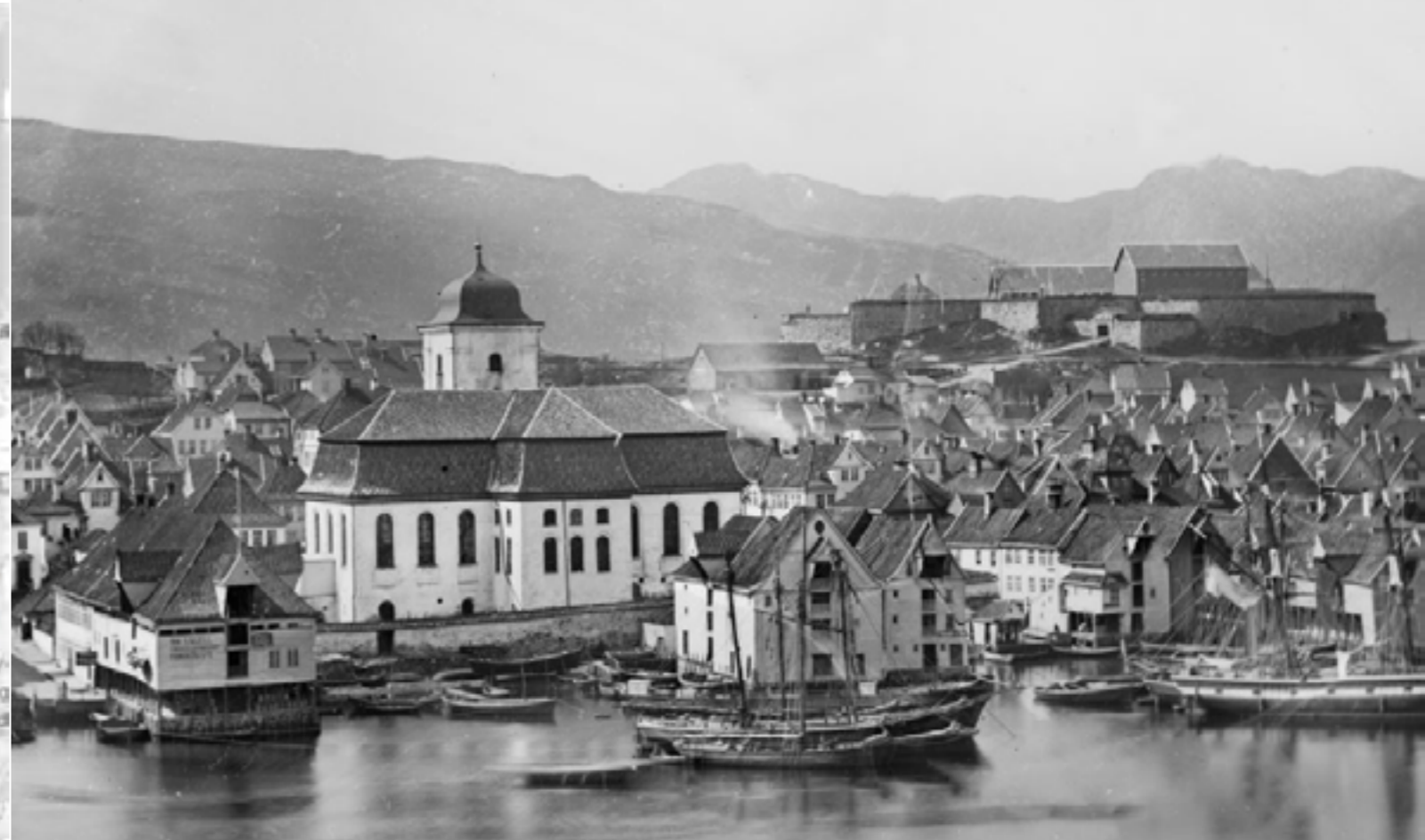
Nykirken i front, med festningsanlegget ruvende bak på ryggen av Nordnes. Festningsanlegget Fredriksberg ble anlagt i 1666 som et ledd i behovet for et større forsvar av byen etter angrepet fra den nederlandske ostindiaflåten i 1665. (kilde: marcus,uib.no/ubb-kk-ns-0489)
