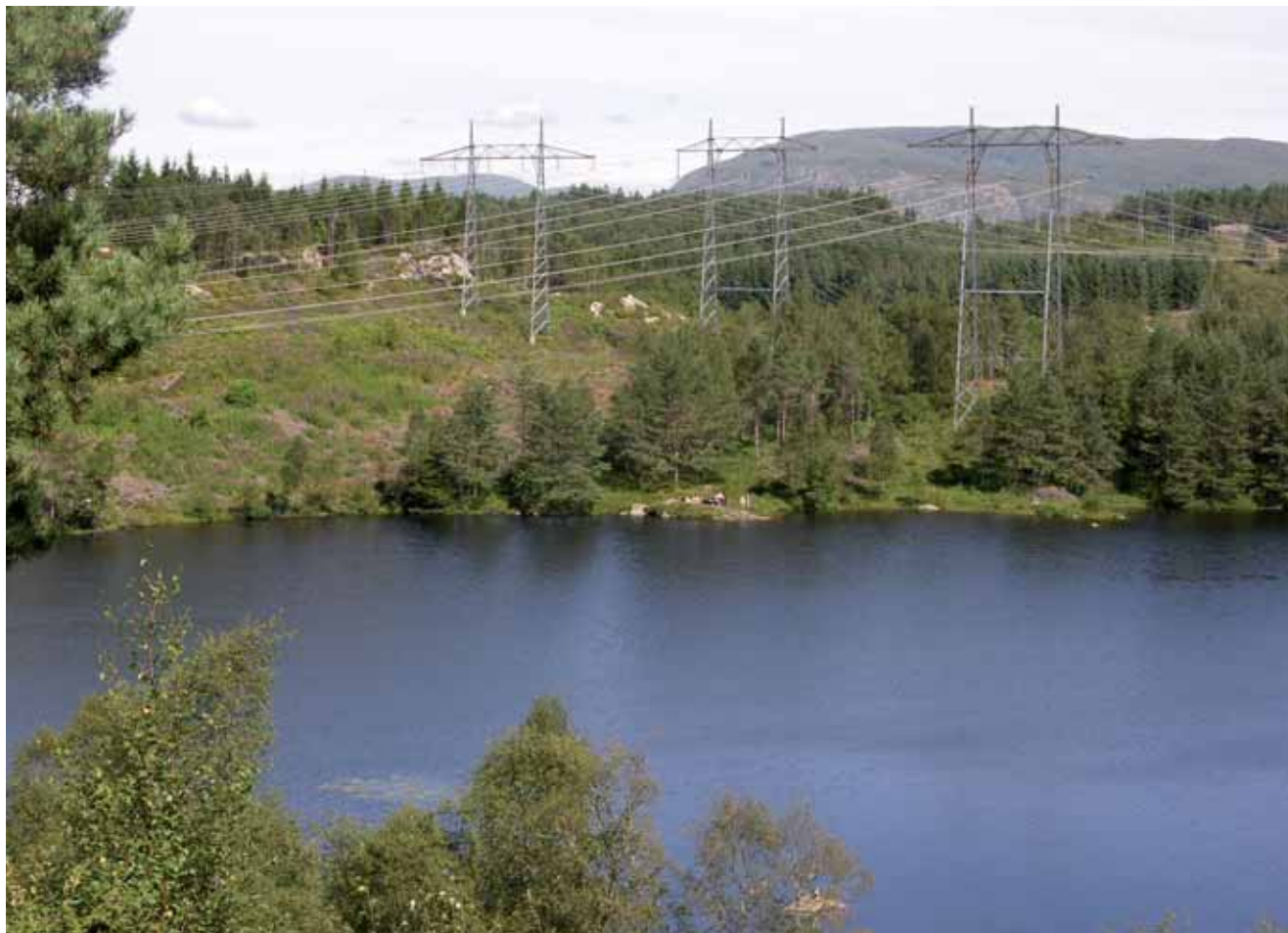
Kraftledning ved Bjørnevattnet.
