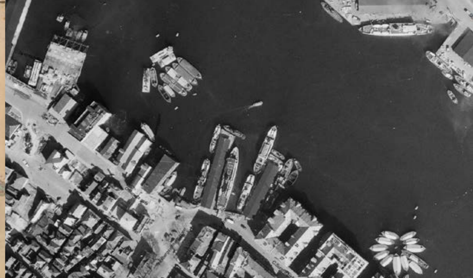
Tradisjonen med bruk av lektere og bøyefortøyning gikk langsomt ut av bruk, men dette flybildet fra 1951 viser at den vedvarte lenge etter at den omfattende kaiutbyggingen i Vågen var gjennomført. (Kilde: xxxxxx)
