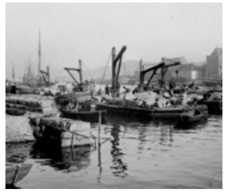
Utbyggingen av steinkaier i Bergen startet på begynnelsen av 1900-tallet. Da fikk man en transformasjon av Vågen fra et sjøbodmiljø til et kaimiljø. Kilde: ubb-bros-02026_md Fundamentering av pakkhus mel 1901 og 1910
