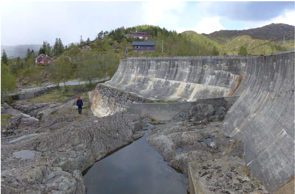
Figur 37: Damanlegget ved Skulstadvatnet ble oppført i naturstein i 1895, men ble i 1955 påbygd med betong. Vannkraften fra dammen ble brukt til å drive kraftstasjonen ved utløpet til sjøen ved Trengereid fabrikker (Foto: Byantikvaren, Bergen kommune 2019).
