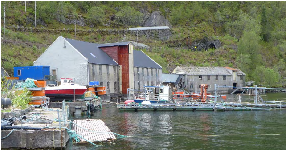
Figur 33: I dag er det bare Stenpakkhuset og den sørligste bygningen som står igjen av fabrikken på Trengereid. Lokalene og området rundt blir i dag hovedsakelig benyttet som lager for ymse marin aktivitet (Foto: Byantikvaren, Bergen kommune 2019).
