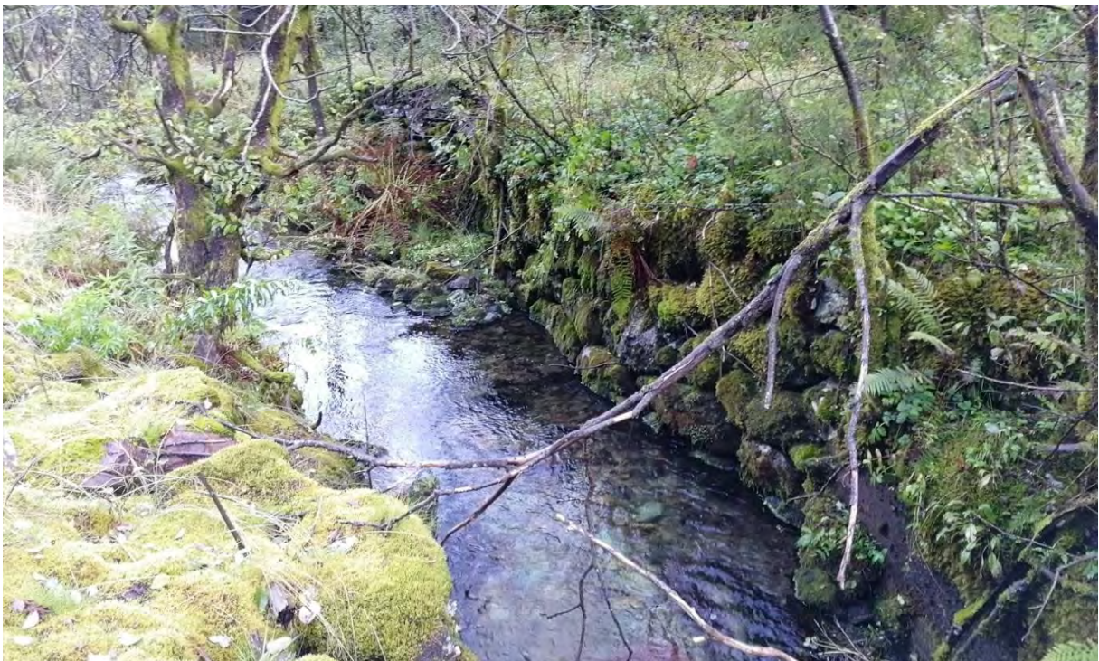
Figur 13: Langs veien mot Manddalselva er det murt opp en flommur av naturstein som skal forhindre utvasking av veien ved høy vannføring i elven (Foto: Byantikvaren, Bergen kommune 2019).
