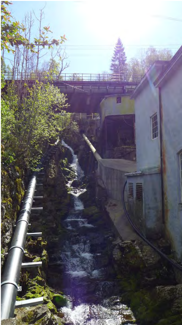
Figur 35: Skulstadelva renner delvis fritt, og delvis i rør til kraftverket. Elva var essensiell i forbindelse med etableringen av industrien på Trengereid (Foto: Byantikvaren, Bergen kommune 2019).
