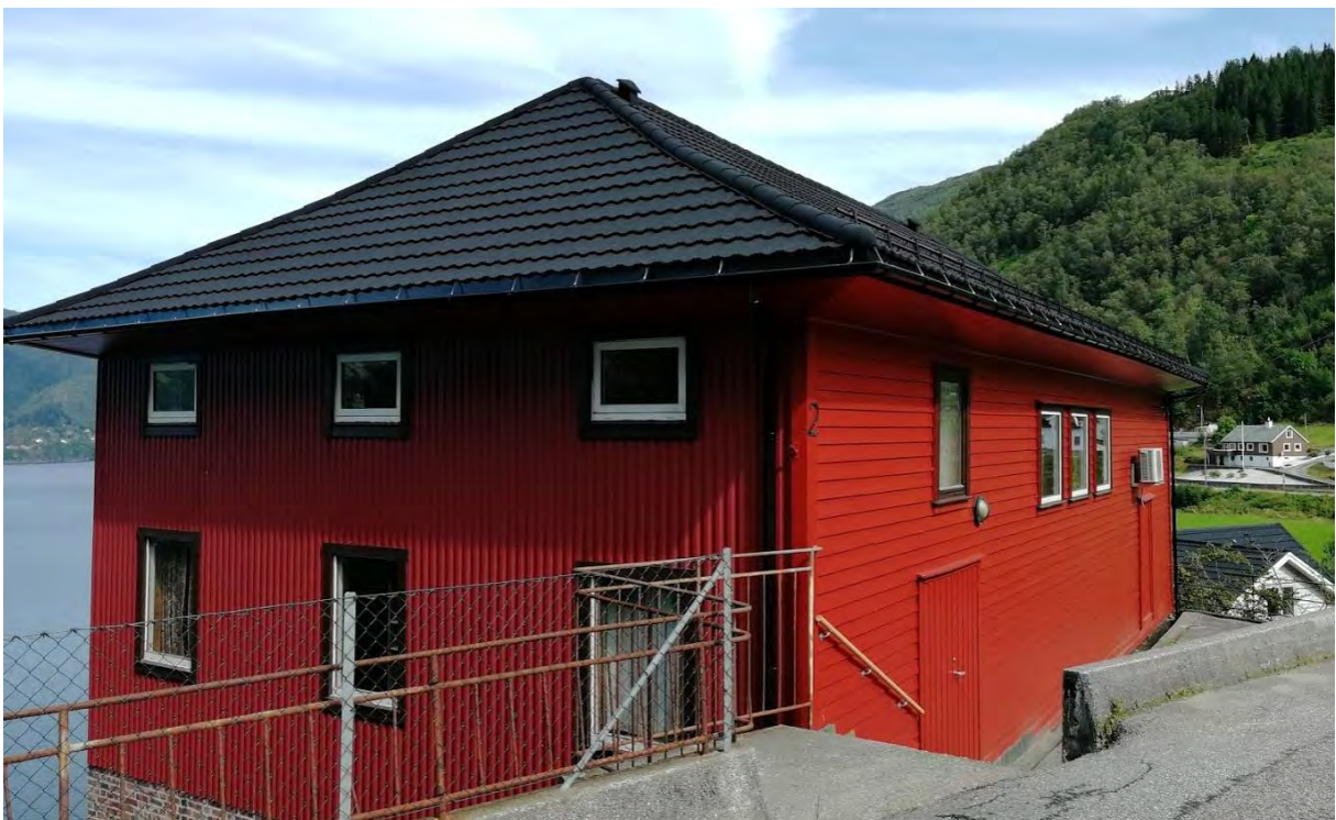
Figur 67: Trengereid forsamlingshus fotografert fra Risnesvegen. Bygningen har nylig fått nytt tak. Opprinnelig hadde bygningen skifertak og to store piper (Foto: Bergen kommune, Byantikvaren 2019).
