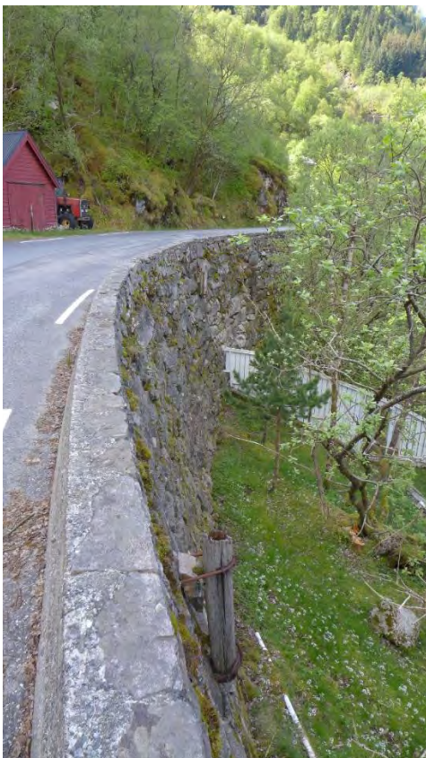
Figur 17: Eksempel på omfattende forstøtningsmurer langs Risnesvegen (Foto: Byantikvaren, Bergen kommune 2019).
