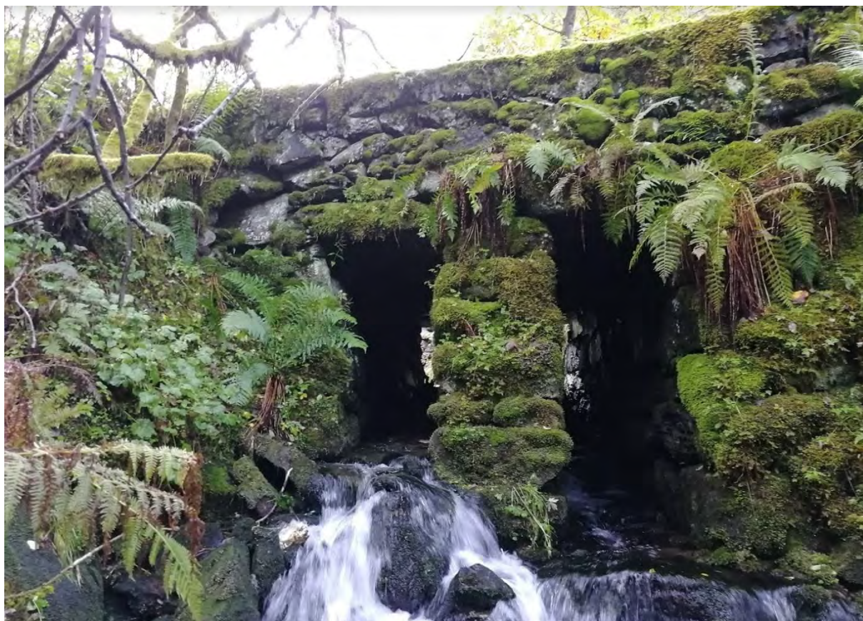
Figur 11: Bru over Manddalselva i Trengereiddalen. Brua er bygd opp av naturstein og har to gjennomløp. Den er trolig en del av Hardangervegtraseen fra slutten av 1800-tallet, uvisst om den kan føres så langt tilbake som til ryddingen av gårdene Dyven (på slutten av 1700-tallet) og Ura (rundt 1815) (Foto: Byantikvaren, Bergen kommune 2019).
