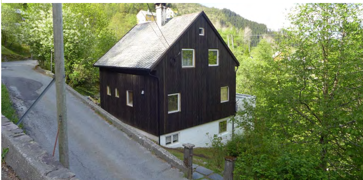
Figur 59: Risnesvegen 52 med svært endret fasade, men med intakt skifertak. Bygningen er noe eldre enn 1950 (Foto: Byantikvaren, Bergen kommune 2019).
