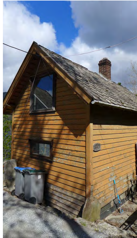
Figur 51: Trengereidbrekka 39, trolig bolig eller næringslokale fra tidlig på 1900-tallet (Foto: Byantikvaren, Bergen kommune 2019).
