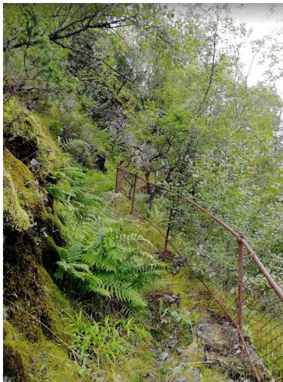
Figur 70: Gangveg langs fjellsiden ut mot Sørffjorden fra Trengereidsbrekka til Risnesvegen (Foto: Bergen kommune, Byantikvaren 2019).
