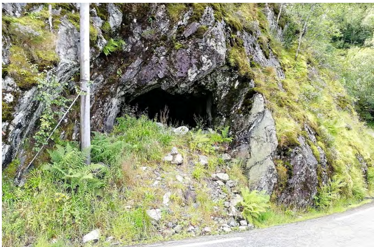
Figur 72: Delvis tildekket tunnelinnslag langs Risnesvegen (Foto: Bergen kommune, Byantikvaren 2019).
