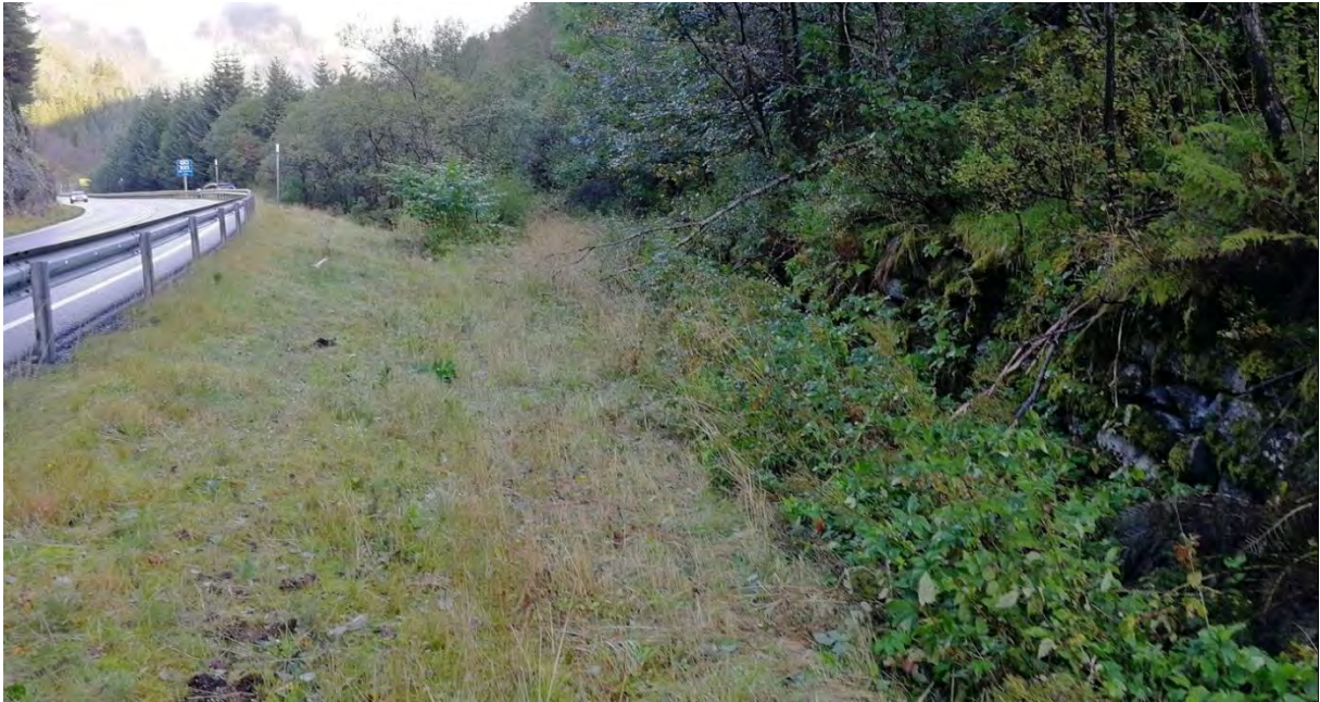
Figur 12: Eldre Hardangervegstrase gjennom Trengereiddalen, trolig fra slutten av 1800-tallet. Langs veien er det murt opp en bakkemur av naturstein som sees til høyre i bildet (Foto: Byantikvaren, Bergen kommune 2019).
