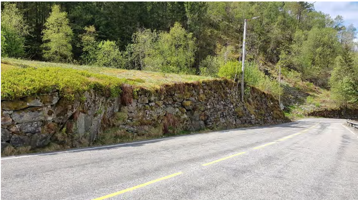
Figur 15: Eksempel på forstøtningsmurer langs Trengereidsvingane. Murene var nødvendige for å kunne etablere vei ned til togstasjonen ved Sørfjorden (Foto: Byantikvaren, Bergen kommune 2019).
