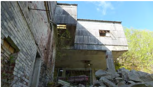
Figur 43: Den største av ruinene etter kalkverket er restene etter bygningen der pakkingen ble utført. Dette er en bygning reist av teglstein og betong (Foto: Byantikvaren, Bergen kommune 2019).
