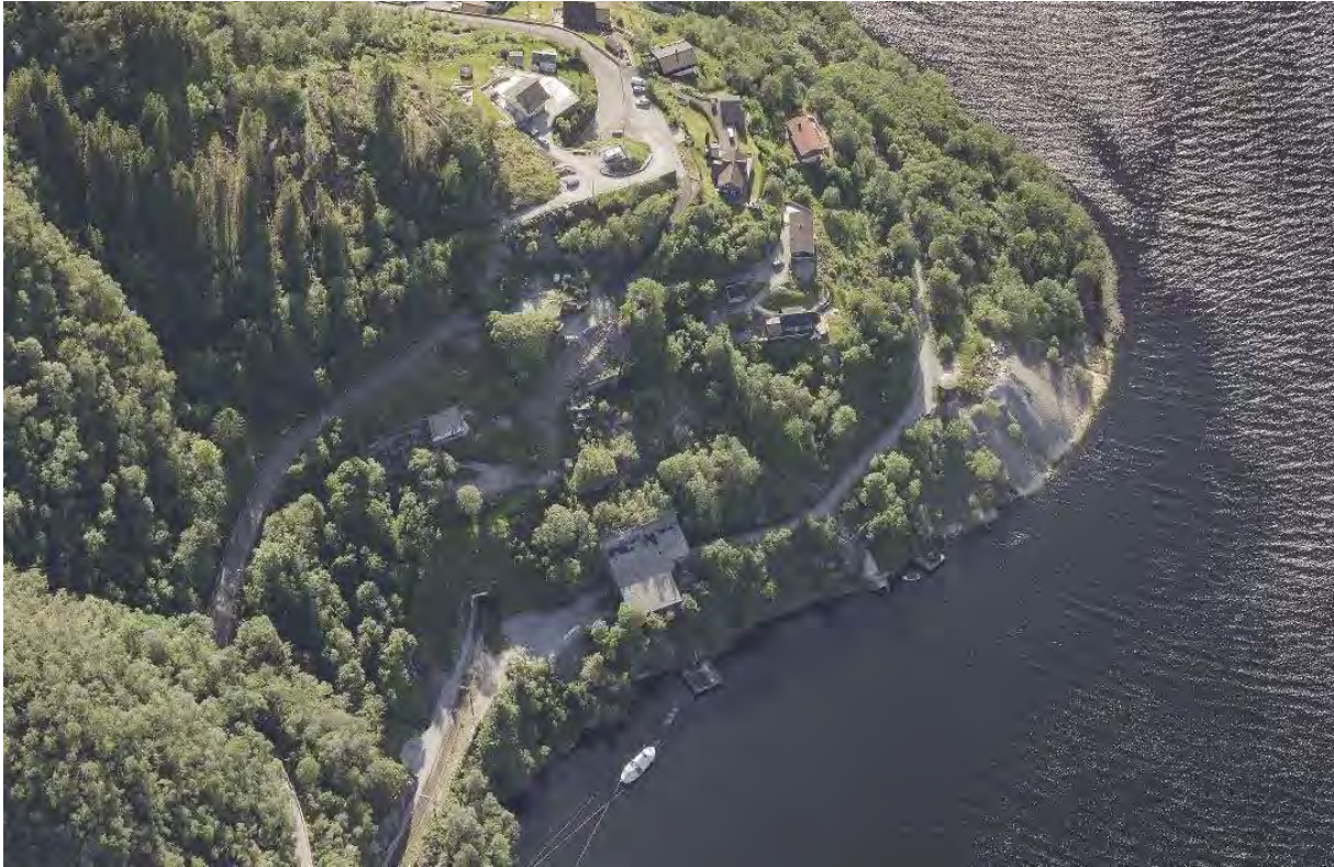
Figur 42: På tross av at kalkverket ble revet etter nedleggelsen, er det mange spor igjen i området. Det er fullt mulig å følge sporene etter aktiviteten fra kaiene ved fjorden og opp til der taubanen kom ned fra fjellet (Foto: Byantikvaren, Bergen kommune 2019).
