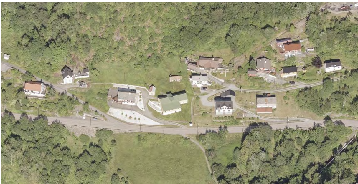
Figur 22: Område for matrikelgården Trengereid. Flere av de eldre bygningene står fortsatt, men det har kommet til noe nyere bebyggelse (Foto: Bergen kommune, Blom 2018).
