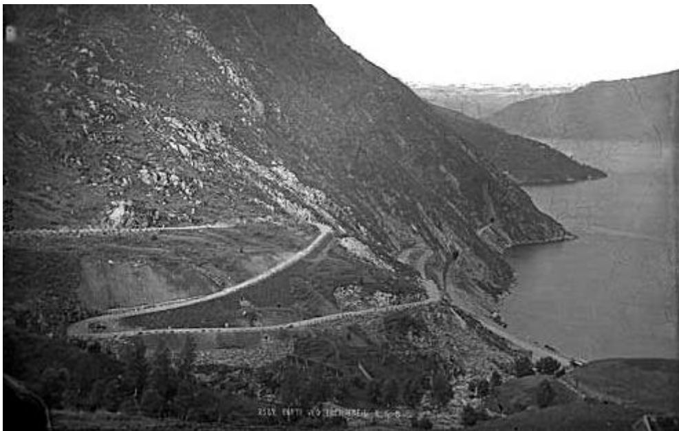
Figur 10: Bildet viser Trengereidsbrekka som ble etablert ned til stasjonen. Vegen er anlagt i et svært kupert landskap. For å få dette til var det påkrevd med støttemurer under veg og bakkemurer i overkant av vei. På bildet skimtes også stabbesteiner, flere står fortsatt i dag. Bildet er tatt mellom 1883-1885 (Foto: UIB, Billedsamlingen Ubb-kk-1318-2589).
