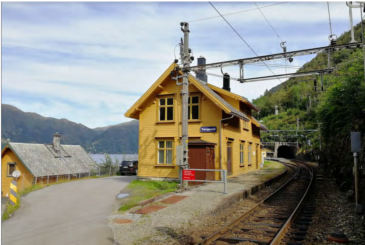
Figur 19: Bilde av Trengereid stasjon slik den fremstår i dag (Foto: Byantikvaren, Bergen kommune 2019).
