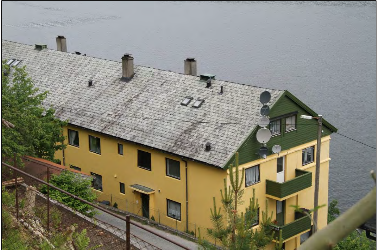
Figur 58. Opprinnelig oppført som hybelhus for kvinner, 1942. Dr. Krohnsveg. E.Tryti (Foto: Byantikvaren 2014).
