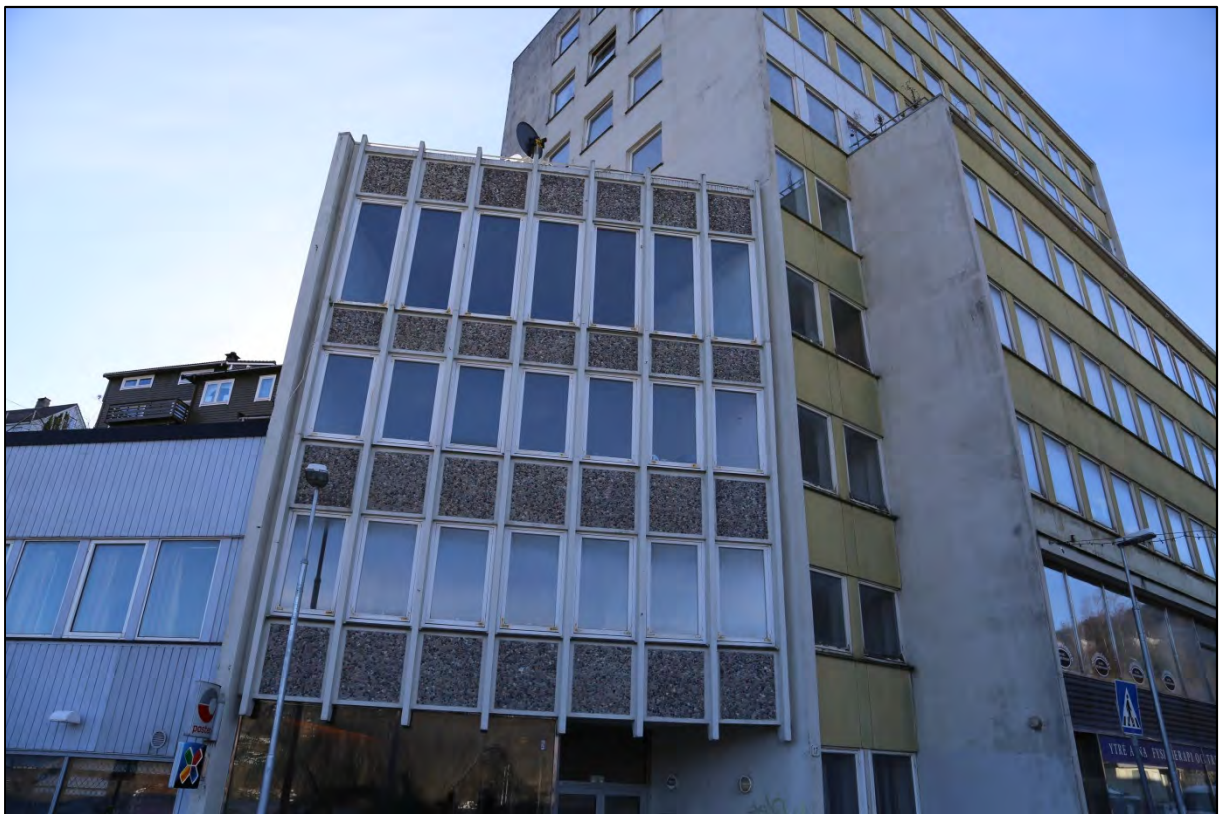
Figur 24. Arnagården, Arne Fabrikkers nye administrasjonsbygg fra 1963, arkitekt Aage Blich (Foto: Byantikvaren 2014).
