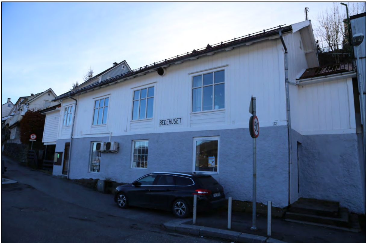
Figur 68. Bedehuset som var det første forsamlingshuset som ble bygget. Det er bygget av materialer fra Mjelde kirke på Osterøy (Foto: Byantikvaren 2015).
