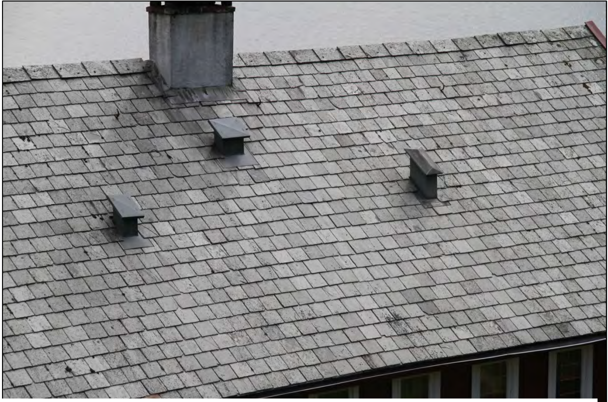
Figur 108. Tak med lappskifer. Bruk av skifer er svært utbredt i Ytre Arna og er et særtrekk som bør videreføres. (Foto: Byantikvaren 2014)
