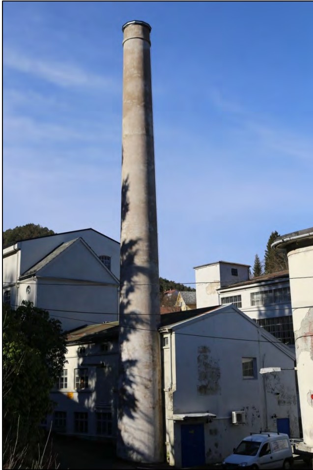
Figur 23. Den nyrestaurerte fabrikkippen ved Arna Industrihus, og deler av det gamle fabrikanlegget (Foto: Byantikvaren 2014).
