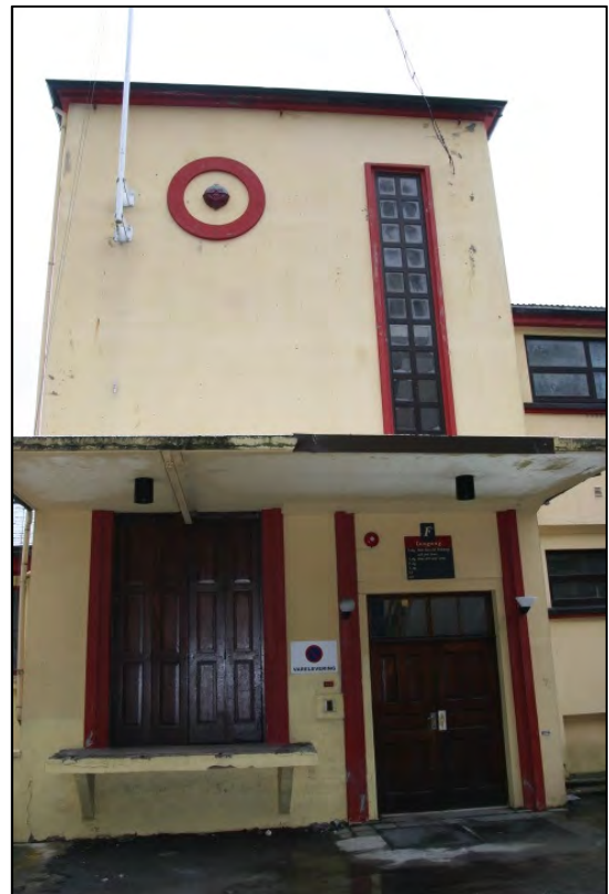
Figur 80. Inngangsparti, bomullsfabrikken (Foto: Byantikvaren 2014).
