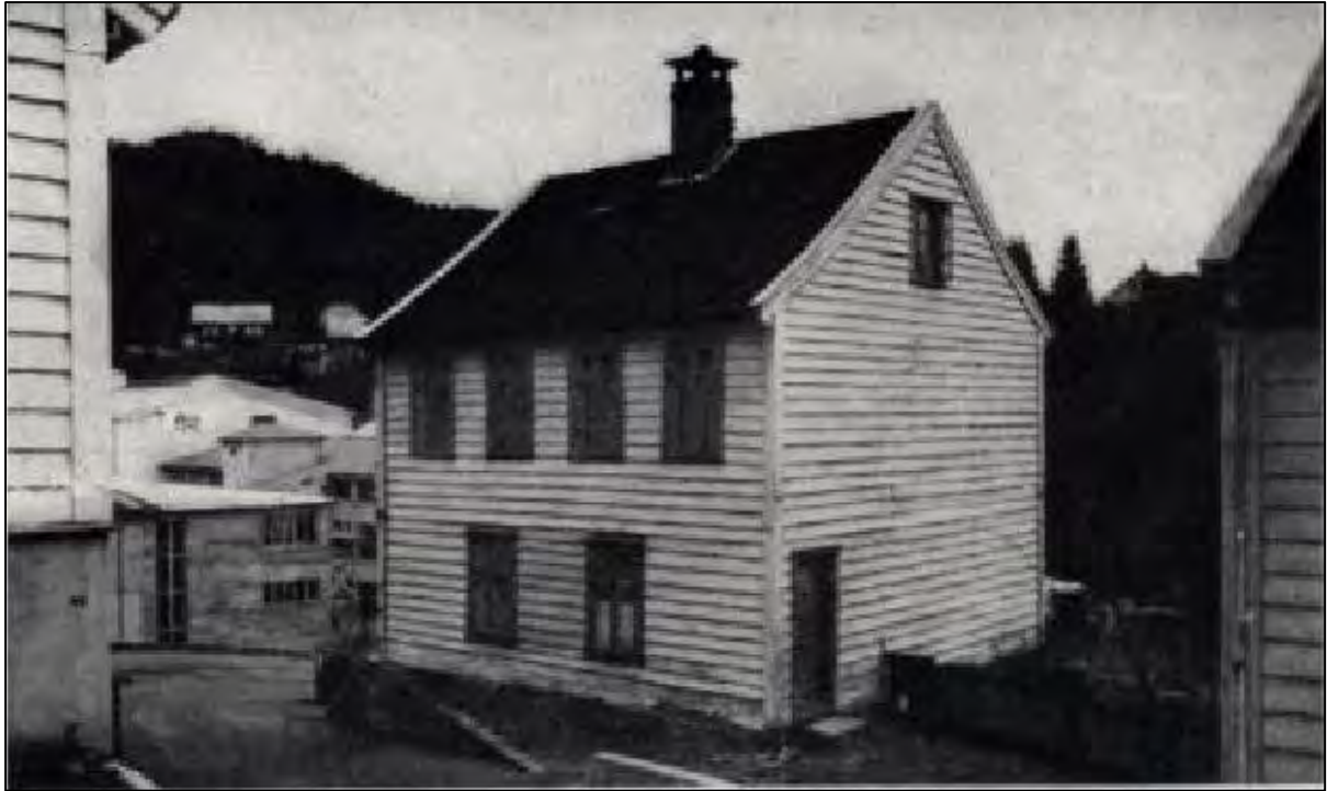
Figur 27. En av de eldste arbeiderboligene i Ytre Arna, i dag revet (Grieg 1946, s. 53).
