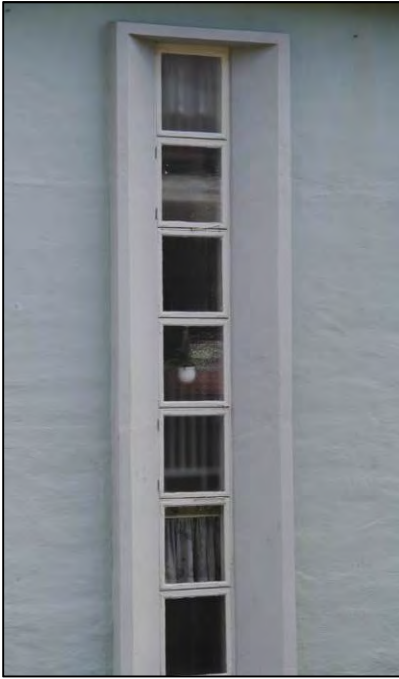
Figur 56. Detalj av vindu i trappehus (Foto: Byantikvaren 2014).
