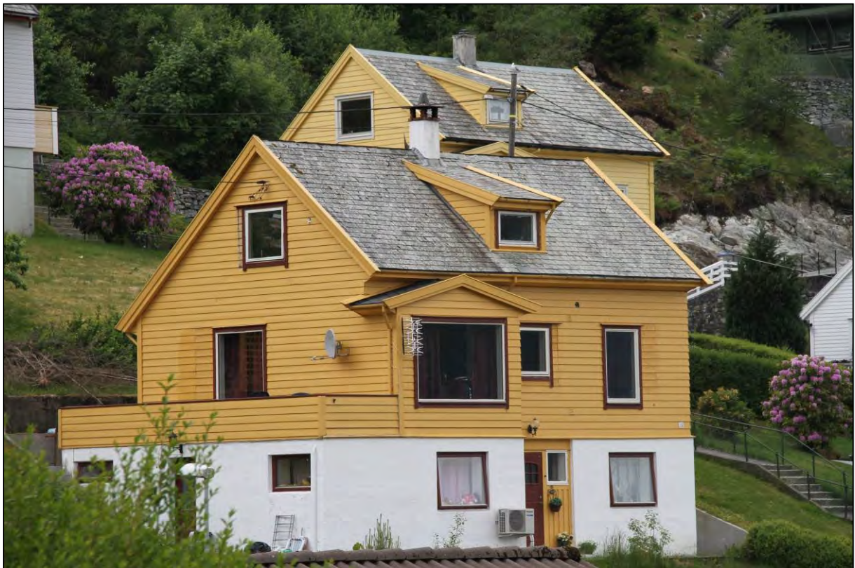
Figur 54. Eksempel på et godt bevart hus i Sætrevegen, tegnet av Tore Tryti 1945 (Foto: Byantikvaren 2015).
