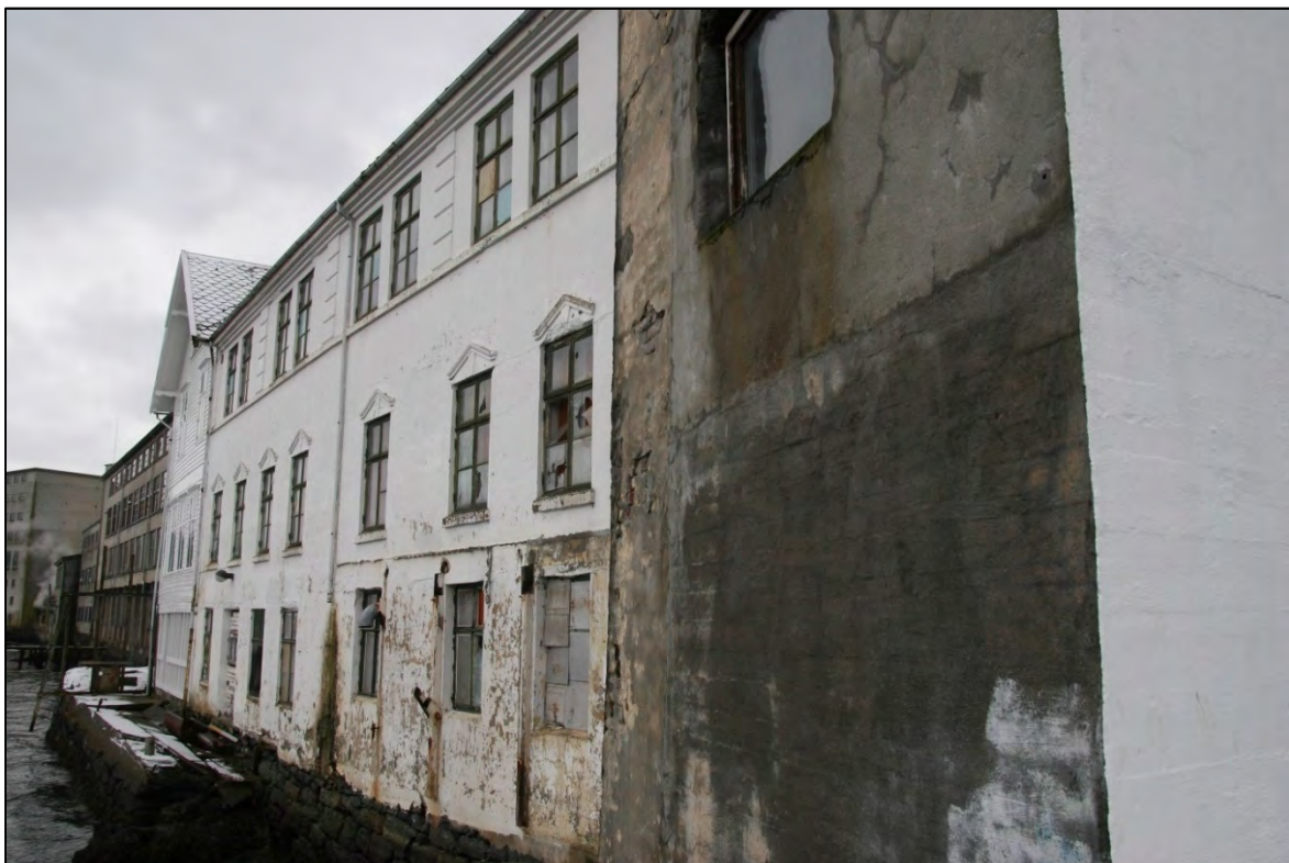
Figur 86. Bygget slik det fremstår i nyere tid mot sjøen (Foto: Byantikvaren 2012).
