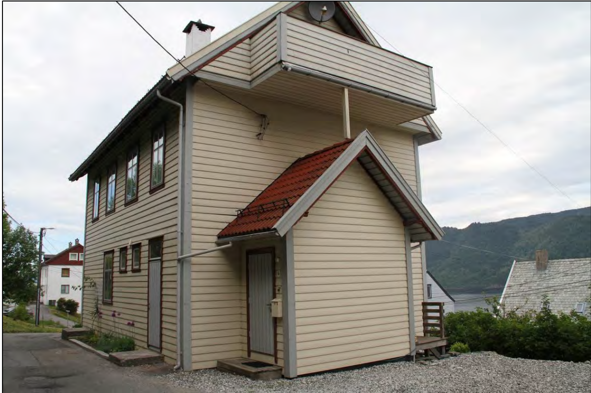
Figur 45. Arbeiderboliger fra 1870-årene med nyere altan, Frydenlundsvegen 4. (Foto: Byantikvaren 2014).
