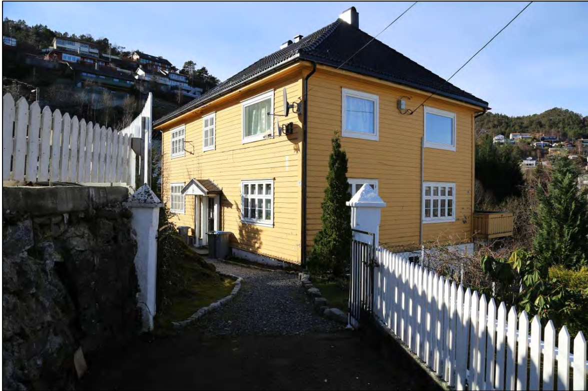
Figur 50. Arbeiderbolig, Gudrun Koldrups veg. Arkitekt Erlend Tryti, 1932 (Foto: Byantikvaren 2014).
