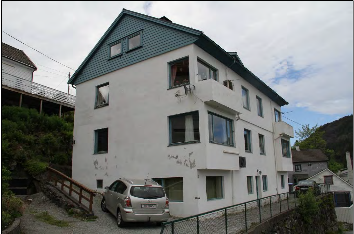
Figur 59. Arbeiderbolig i Alf Bondes veg, oppført i 1942. Arkitekt E. Tryti (Foto: Byantikvaren 2014).
