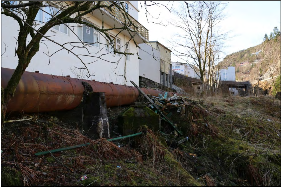
Figur 96. Bevart rørgate like i kant med kulturhuset (Foto: Byantikvaren 2014).
