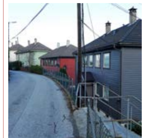
Flermannsboliger i tre langs Herman Grans vei. Veisystemet og bygningene "klatrer" i det bratte terrenget og er knyttet til Kringsjøveien og Herman Grans vei av interne trapp- og gangforbindelser.
