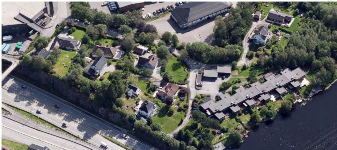
Figur 29: Atriumrekkehus i Forvasshaugen 16-26 (Foto: Blom Urbex, 2019)
