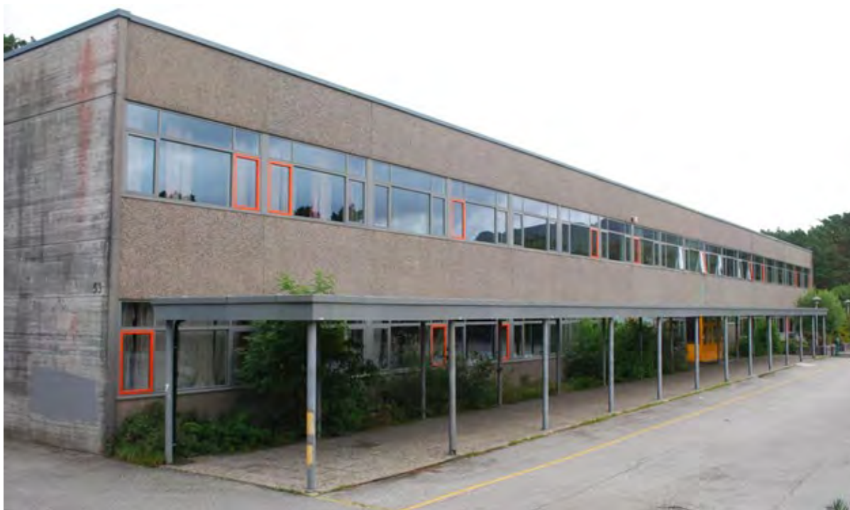
Figur 36: Blokkhaugen skole fra 1976. Tegnet av arkitekt Sigmund Myking Byantikvaren, 2013)
