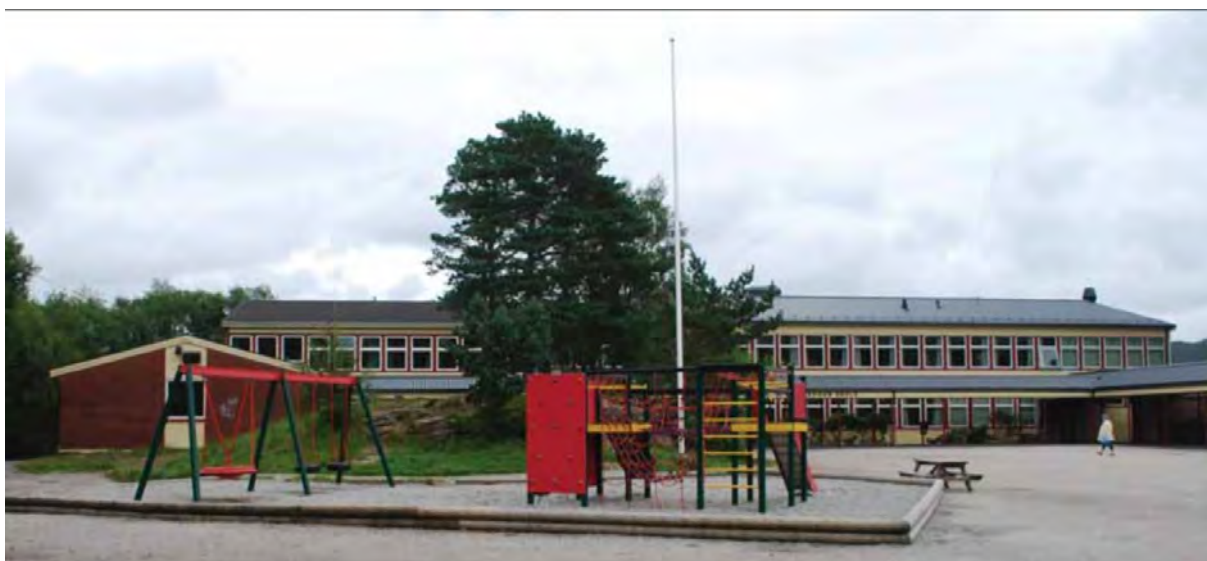
Figur 37: Ulsetskogen skole. Hovedfløyen er en langstrakt bygning med vindusbånd. (Foto: Byantikvaren, 2013)
