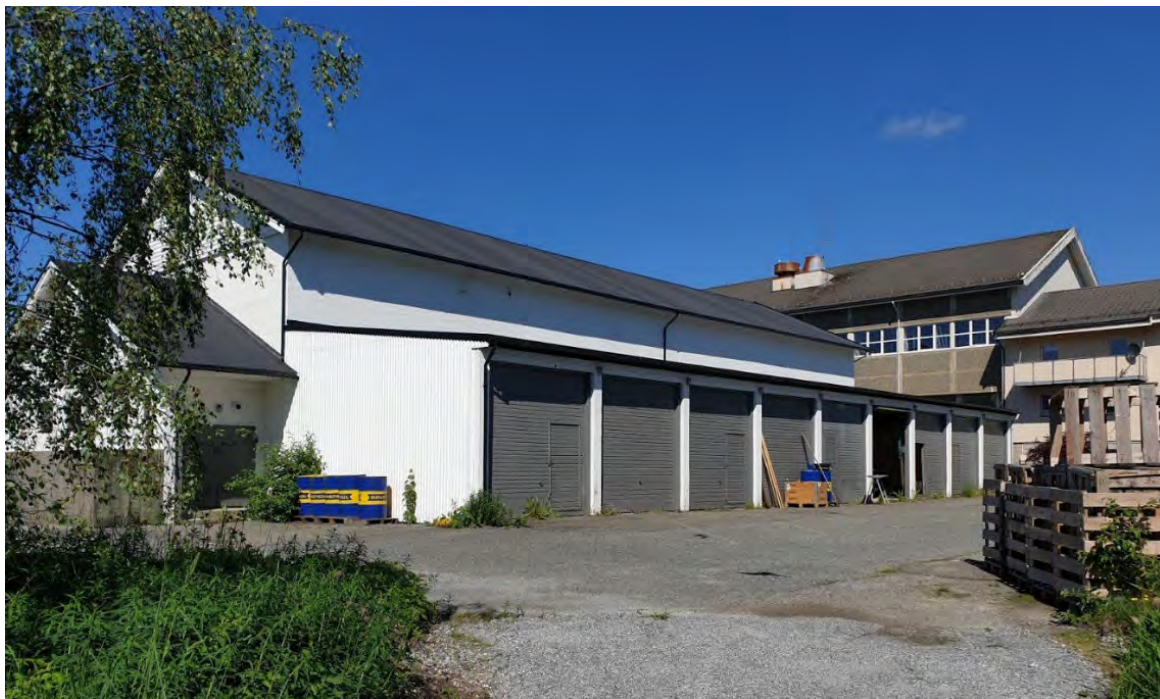
Figur 33: Gass og trykksikker bunker fra 1966 (Foto: Byantikvaren 2021).
