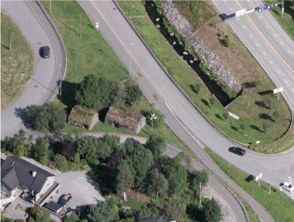
Figur 8: De to torvhusene (midt på bildet) på Saurås ligger sørvest for store, tidligere myrområder der vi i dag finner bl.a. IKEA, og er regulerte til bevaring i gjeldende reguleringsplan (Foto Blom Urbex)
