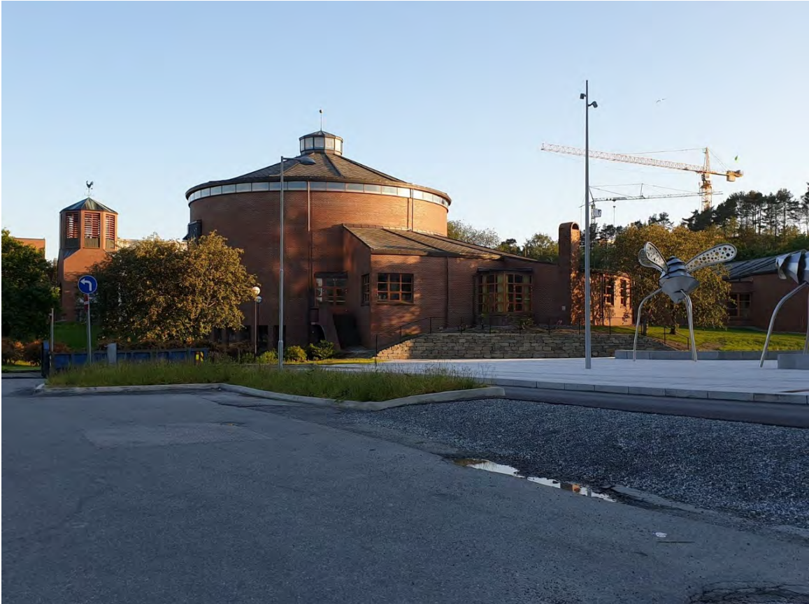
Figur 32: Åsane nye kirke, kranen vitner om pågående utbygging av Midtbygda sykehjem. Til høyre i bildet skulpturer satt opp foran den nye Åsane VGS og kulturhuset i Åsane. (Foto: Byantikvaren 2021)
