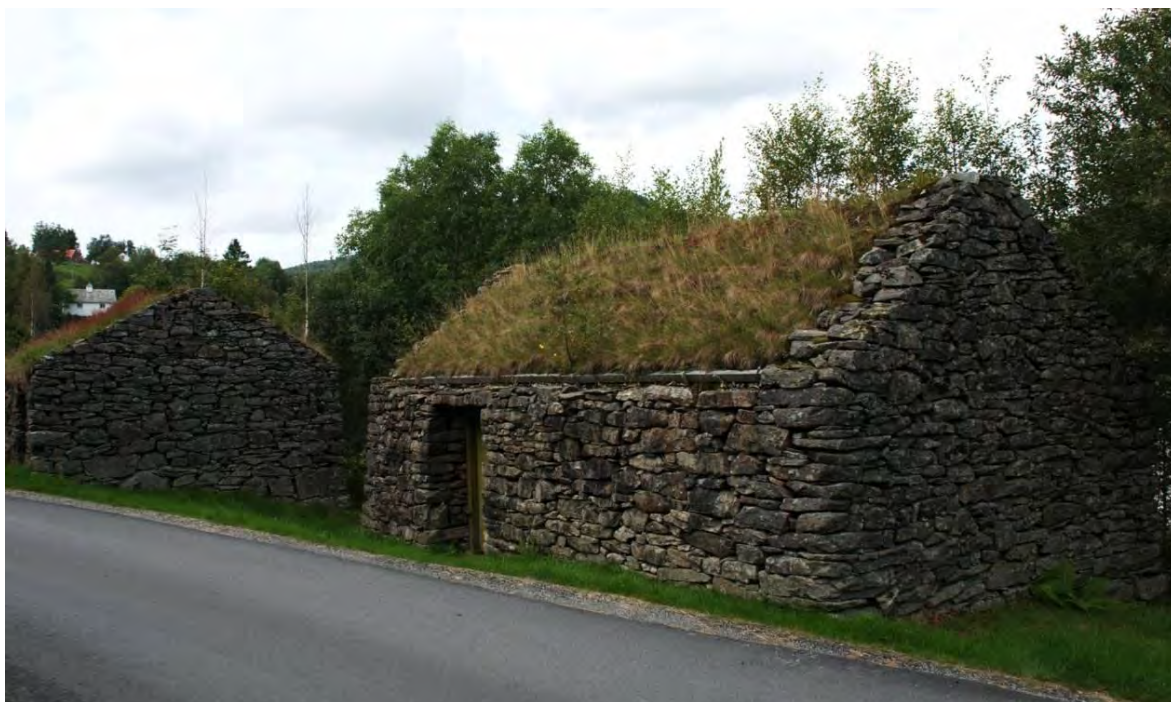
Figur 7: Typiske torvhus av stein, en hustype som har vært vanlig i Åsane i forbindelse med utvinningen av torv som brensel. Disse ligger på Saurås bnr.1, mellom Dalavegen og Sauråsbakken. (Foto: Bergen kommune 2010).
