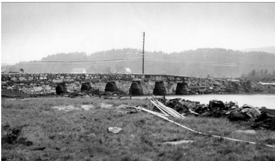
Figur 20: Håbrua over Dalaelva, ved grensen mellom gårdene Ulset og Rolland blir omtalt som den vakreste utkragebroen som noen gang er bygget i Hordaland. Foto: Digitalmuseum.no, ukjent fotograf.
