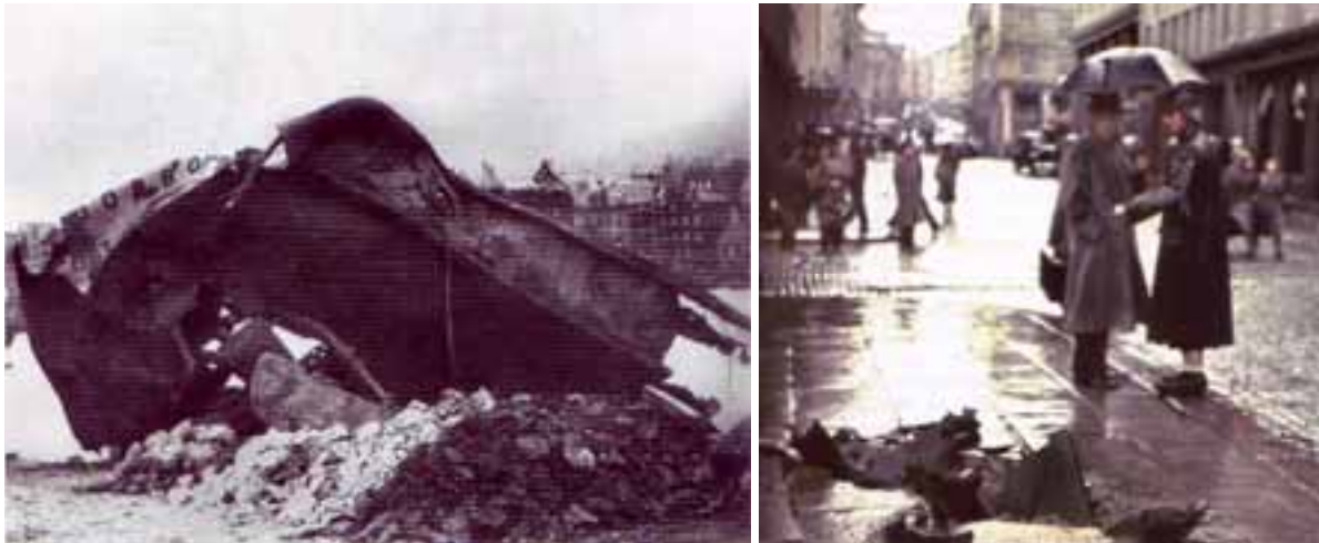
Figur 16 Del av Voorbode på festningskaaien til venstre. Til høyre deler av Voorbode eller Krosdøl som havnet ved Byparken, 1 km fra eksplosjonsstedet (Strand 2009:17, 59)
