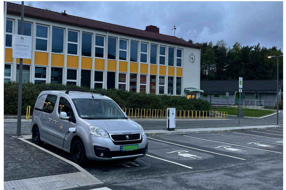
Bilde: Ladepunkt etablert ved Varden skole. Foto: Bergen kommune.
